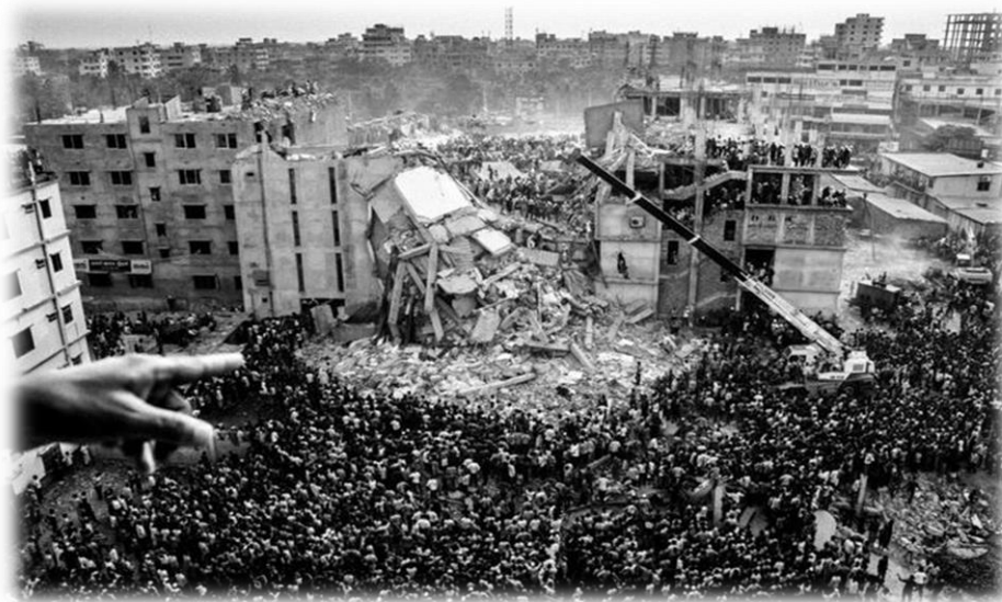
Figura 13 - Escombros do desastre em Rana Plaza, Bangladesh (Talukde, 2013)
