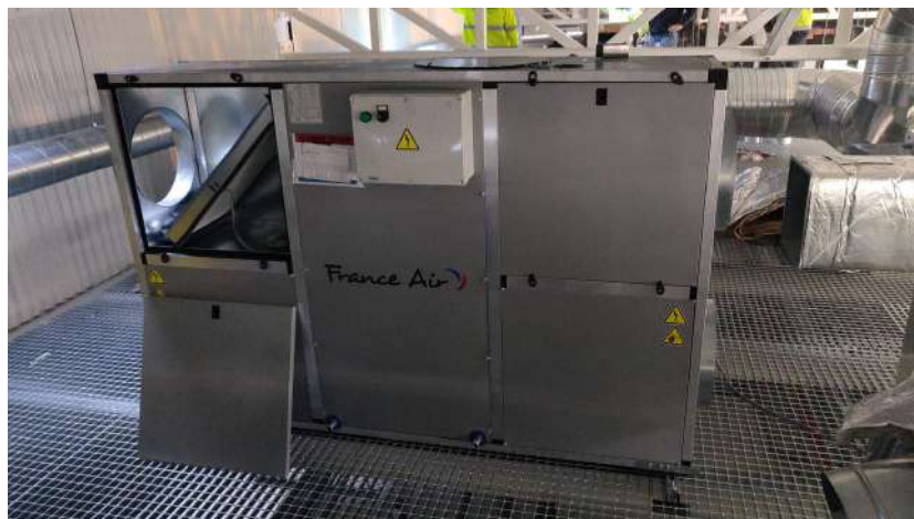
Figura 16 - Recuperador de fluxos cruzados
