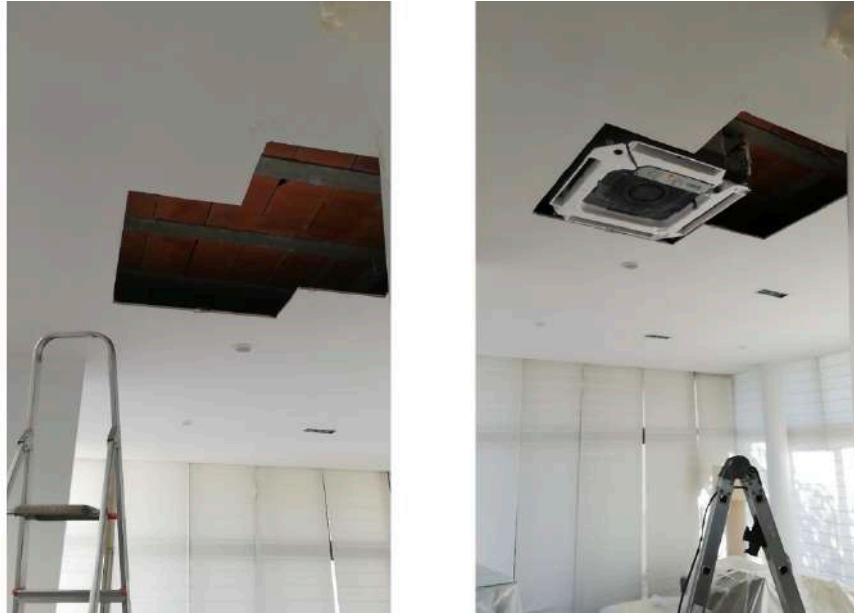
Figura 28 - Preparação dos trabalhos para instalação de uma cassete de 4 vias
