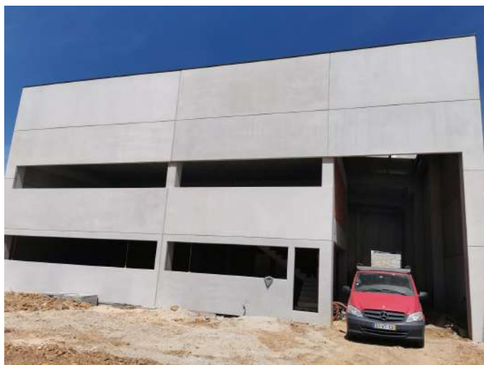
Figura 2 - Futuras instalações da Infiniplus.
