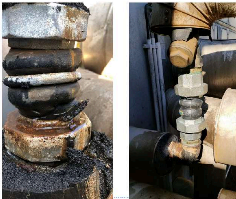
Figura 27 -Substituição de junta antivibrática do circuito de água fria de uma UTA.
