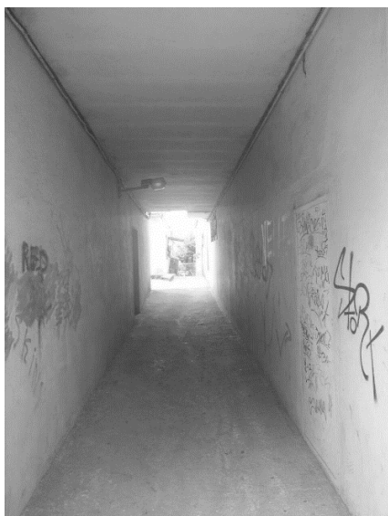
Figura 21: Edificación legal construida sobre un antiguo camino rural por lo que para el acceso a las viviendas se ha tenido que realizar este túnel en el interior del edificio.
