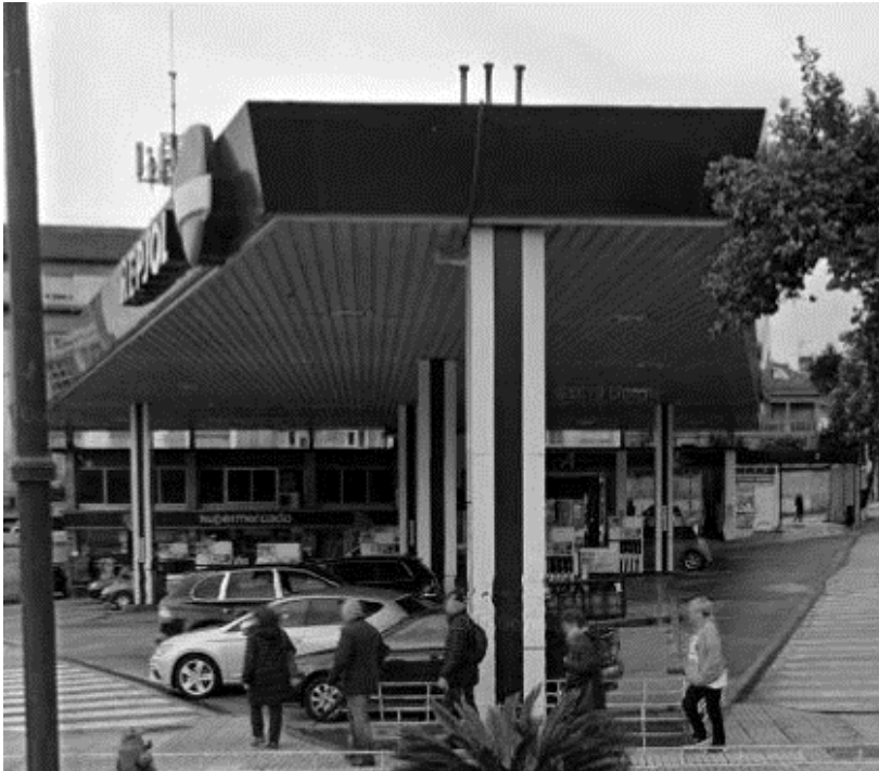
Figura 26: Gasolinera de Plaza España.
