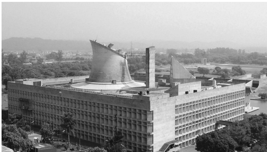
Vista del Capitolio desde la cubierta del Secretariado. Foto: Sagrario Fernández Raga
