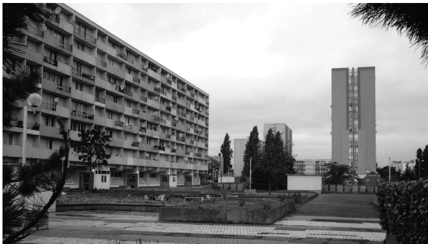
Los programas de renovación urbana de Bobigny-Centre Ville (Bobigny, Seine-St-Denis), (a la izquierda) y de Les Fauvettes (Neuilly-sur-Marne, Seine-St-Denis), (a la derecha) y prevén la demolición de las dalles
