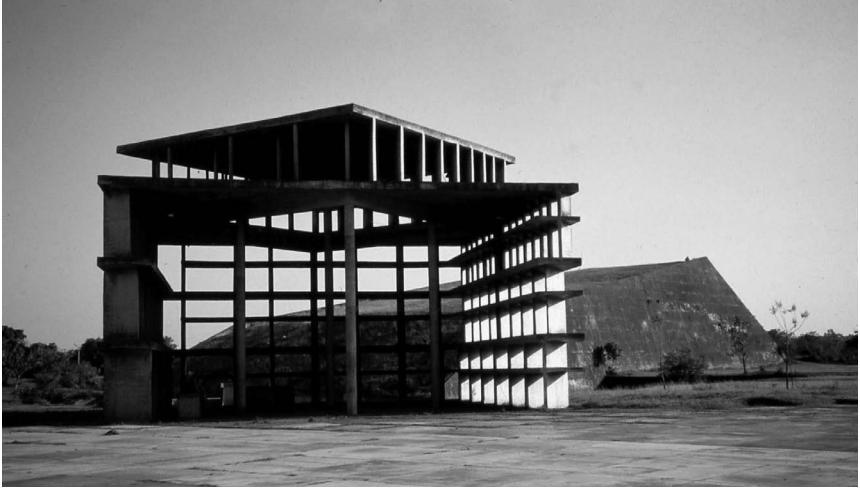
Torre de las Sombras y Montaña artificial. Foto: autor
