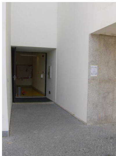
Imagem 5 – Porta de acesso ao edifício na ala da creche
