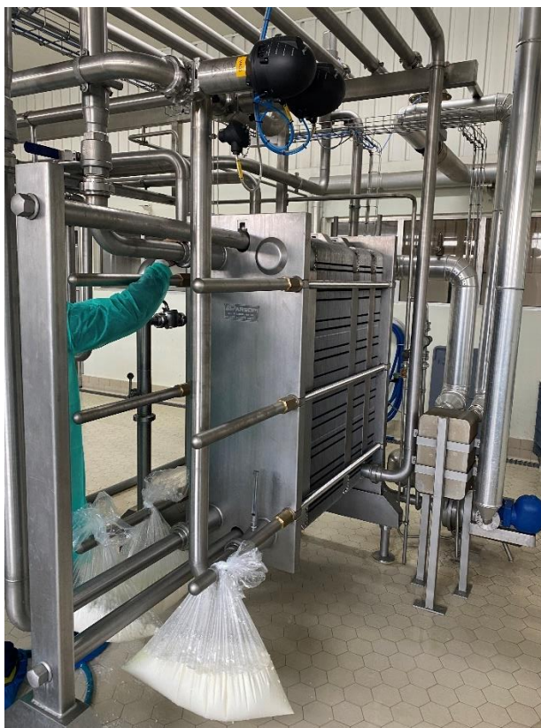
Figura 5.4 - Instalação da alteração 2
