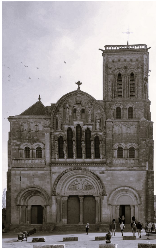
Figura 14 Obra de restauro, ultima imagem, da Igreja de Madaleine de Vezelay em França, por Viollet-le-Duc
