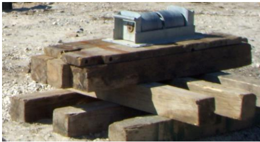
Figura 32 - Apoios provisórios de lançamento constituídos por roletes cilíndricos (Companhia de Pontes, 2014)
