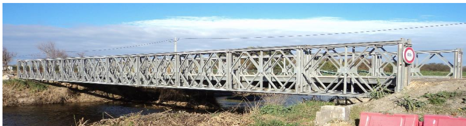
Figura 27 - Ponte Mabey montada em Mira
