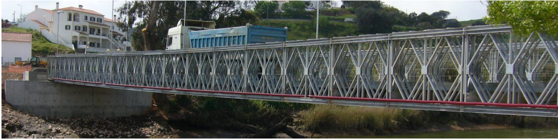
Figura 60 - Ensaio de carga na ponte Mabey (Companhia de Pontes, 2011)
