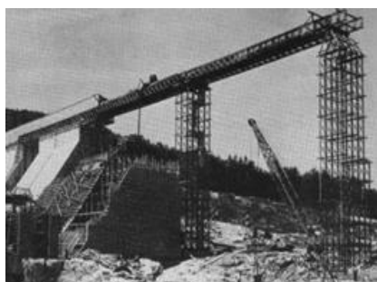
Figura 23 - Sistema de painéis da ponte Bailey a servir de pilar em Des Joachims, Canadá (Thinkdefence, 2012)
