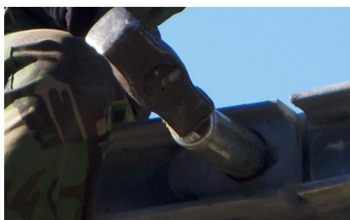
Figura 64 - Colocação de uma cavilha (Companhia de Pontes, 2013)
