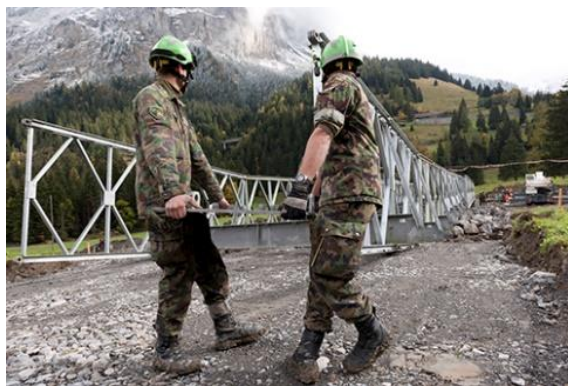
Figura 14 - Ponte logística utilizada pelo Exército Suíço em apoio à população local (Mabey Bridge, 2013)
