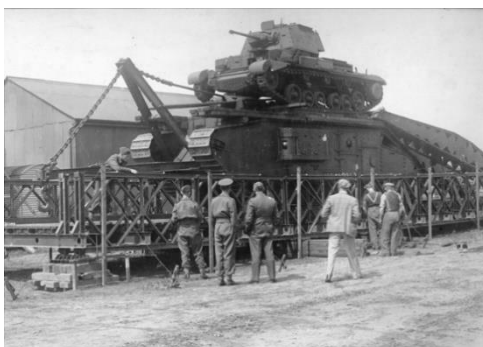
Figura 3 - Ensaio de carga na Ponte Bailey (Thinkdefence, 2012)
