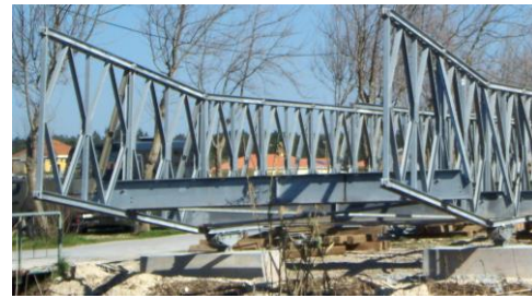
Figura 33 - Nariz de lançamento (Companhia de Pontes, 2014)
