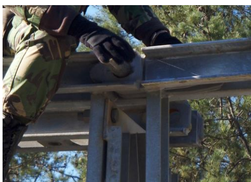
Figura 62 - Montagem da cavilha entre painéis (Companhia de Pontes, 2013)
