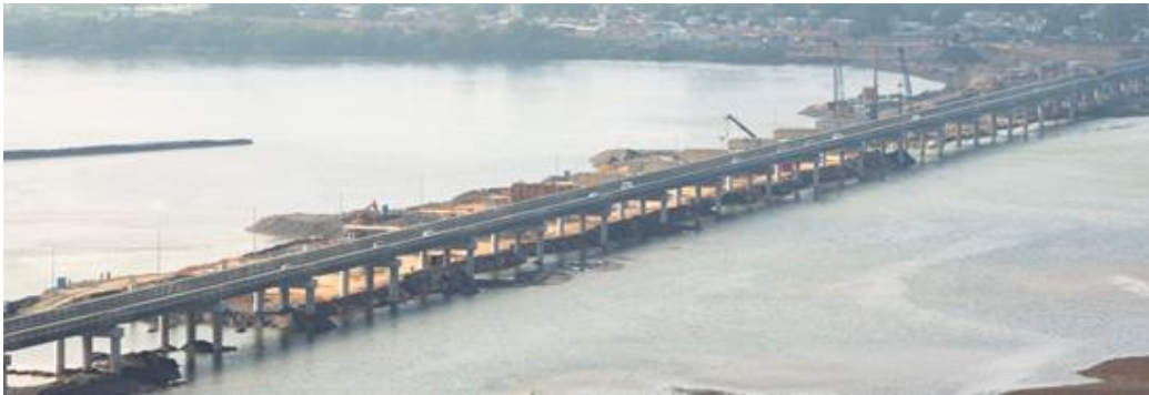
Figura 7 - Ponte Acrow sobre o rio Biobío no Chile (Acrow Bridge, 2014b)
