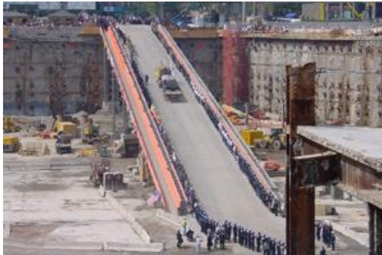
Figura 10 - Ponte Acrow montada em Nova Iorque após o 11 de setembro de 2001 (Acrow Bridge, 2014a)
