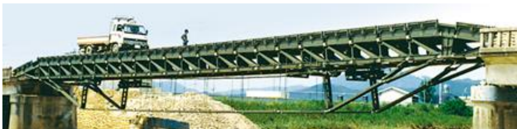
Figura 5 - Medium Girder Bridge, montada em sistema duplo com reforço nos apoios (WFEL, 2014b)
