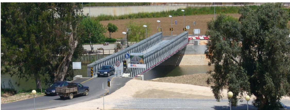
Figura 36 - Ponte Mabey em Odemira na configuração TSHR3H (Companhia de Pontes, 2011)
