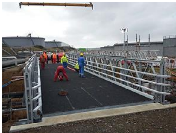
Figura 15 - Ponte Compact 200 a apoiar a manutenção de oleodutos (Mabey Bridge, 2014a)
