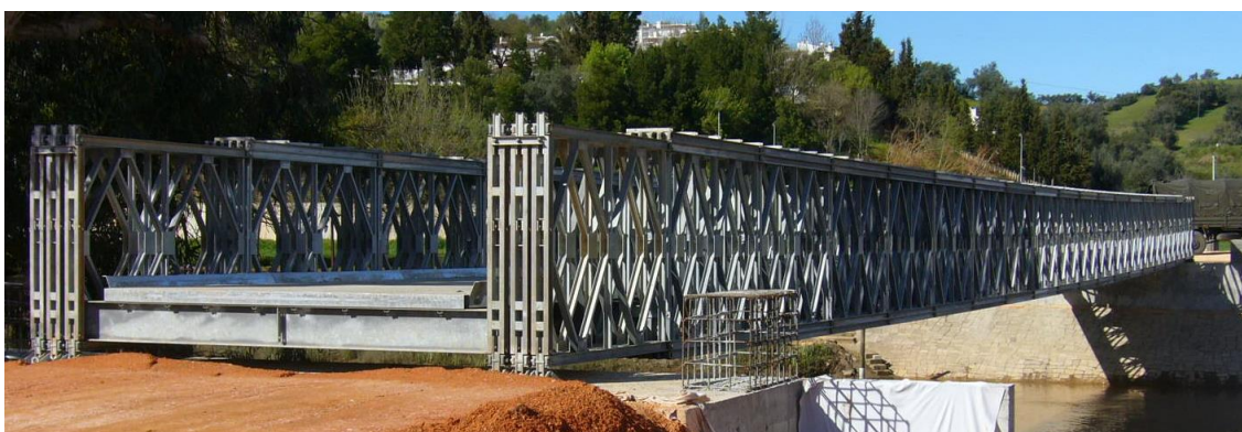
Figura 35 - Ponte Mabey montada em Odemira, Beja (Companhia de Pontes, 2011)
