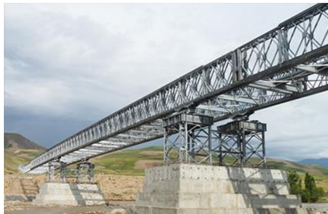
Figura 22 - Ponte Mabey com apoios intermédios (Mabey Bridge, 2014a)
