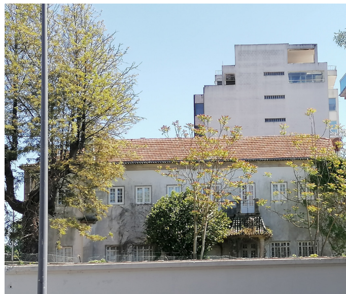
Imagem 109 | Registo fotográfico da lateral do edifício de intervenção da direita, em 2021
