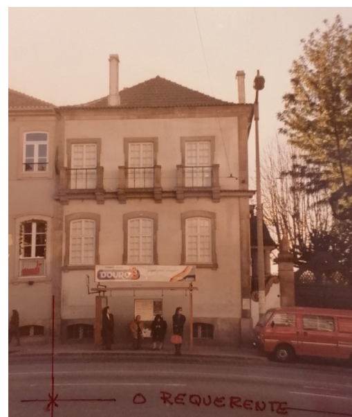
Imagem 099 | Registo fotográfico do edifícios de intervenção do lado direito, em 1990
