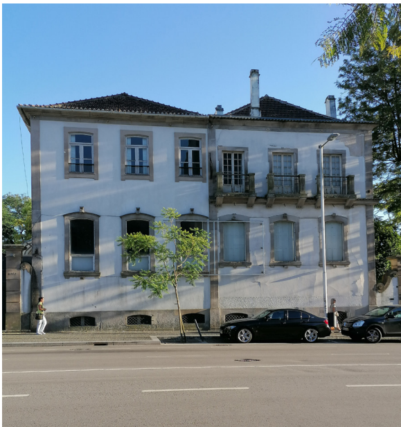
Imagem 104 | Registo fotográfico fachada dos edifícios de intervenção, em 2020
