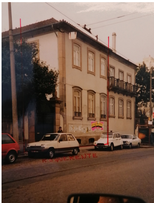
Imagem 097 | Registo fotográfico do edifício de intervenção do lado esquerdo, em 1998
