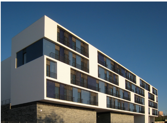
Imagem 027 | Registo fotográfico da fachada de trás com a fachada lateral direita | Residência Madre Maria Clara
