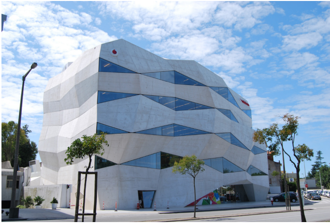
Imagem 093 | Edifício Vodafone, ano 2010
