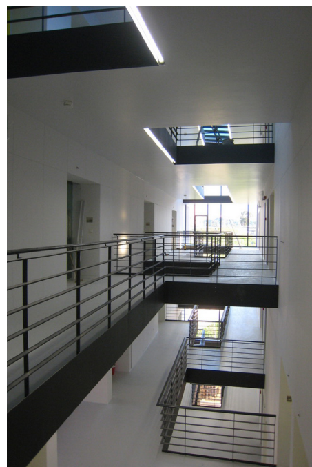
Imagem 031, 032 e 033 | Registo fotográfico da transparência vertical entre todos os pisos Residência Madre Maria Clara
