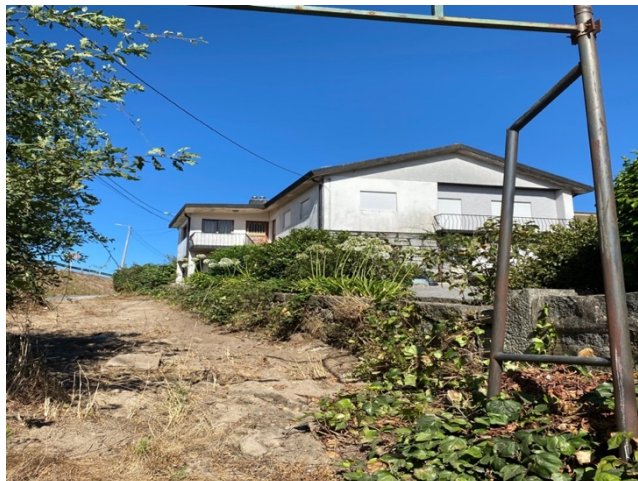
Ilustração 24.5 - Área de intervenção – Fotos da envolvente do terreno
