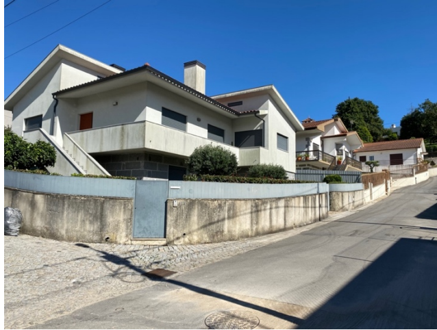
Ilustração 24.3 - Área de intervenção – Fotos da envolvente do terreno
