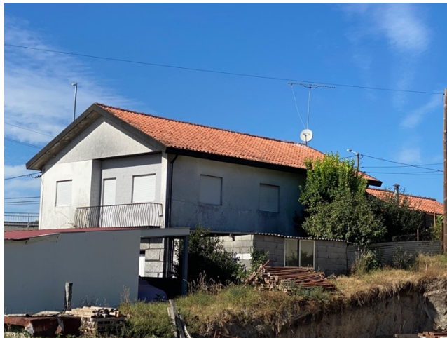
Ilustração 24.4 - Área de intervenção – Fotos da envolvente do terreno
