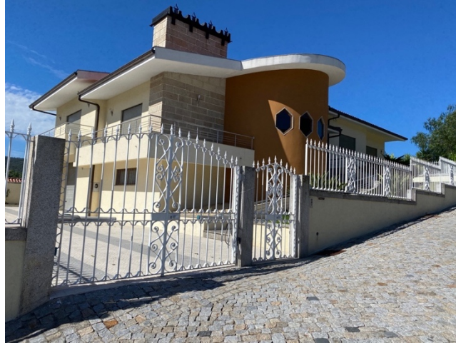
Ilustração 24 – Área de intervenção – Fotos da envolvente do terreno
