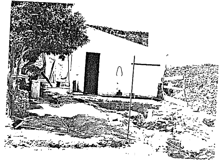
CASA DO COVEIRO RESTAURADA PELOS MONUMENTOS NACIONAIS EM 1978 ARABAMENTOS EM 1980
