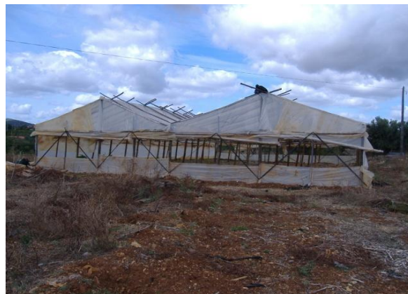
Figura 29 - Estufas em madeira tipo capela
