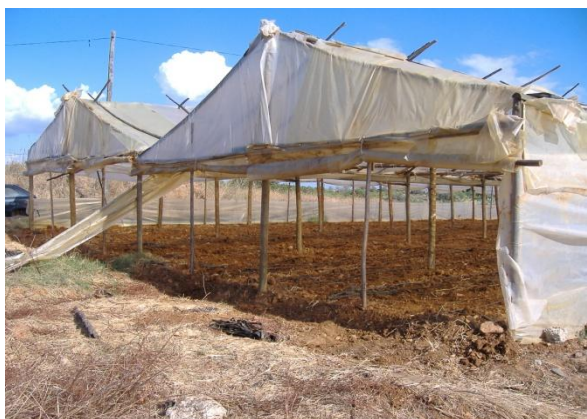
Figura 18 - Vista geral das estufas da zona (a)
