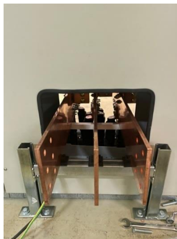
Figura 20 – Fixação do barramento de entrada no Quadro
