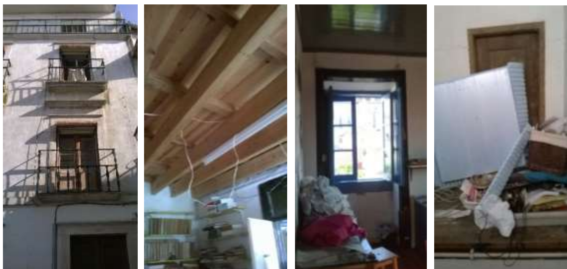
Figura 3.5 – Vista de uma fachada; cobertura em madeira; caixilharias das janelas em madeira; compartimentação de arrumação
