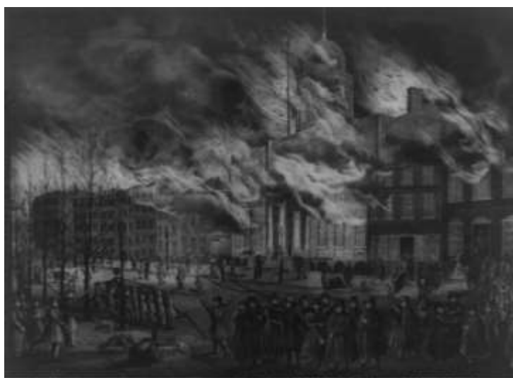
Figura 2.11 – Incêndio em New York [9]
