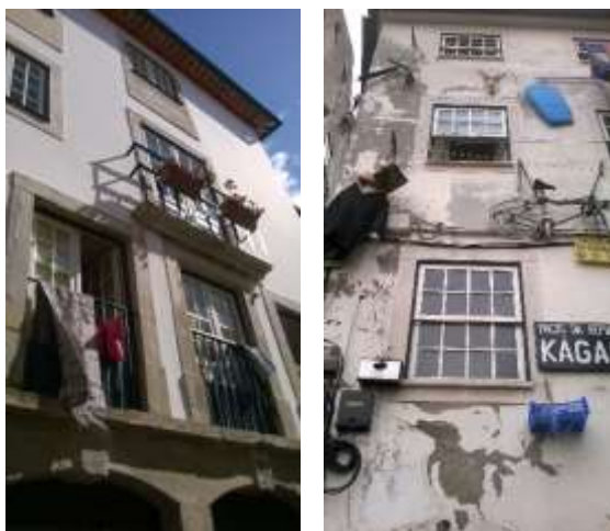
Figura 4.1 – Edifício reabilitado; edifício degradado
