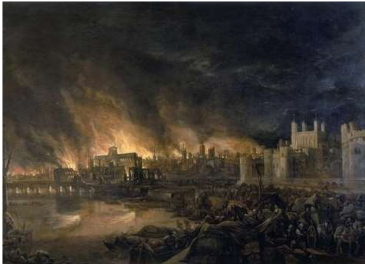
Figura 2.8 – Incêndio de Londres [6]
