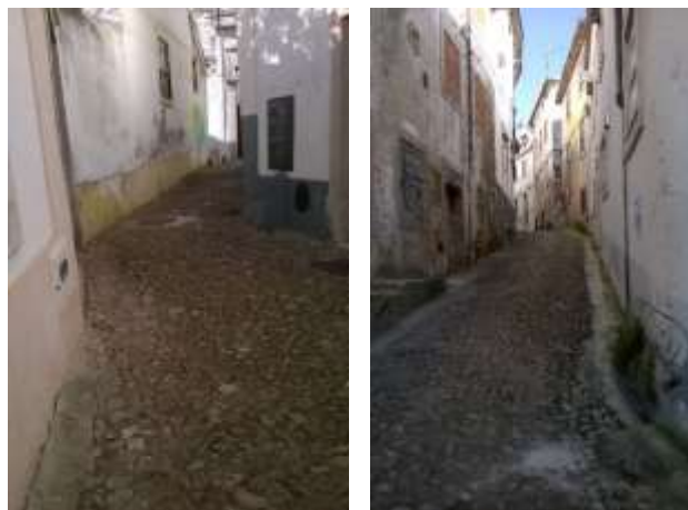
Figura 4.6 – Edifícios em confronto muito próximo
