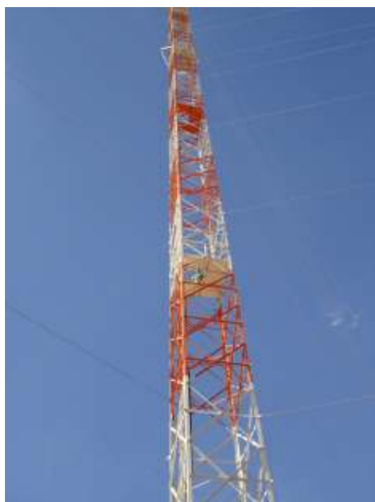
Figura 3 – Medição na plataforma de serviço da torre
