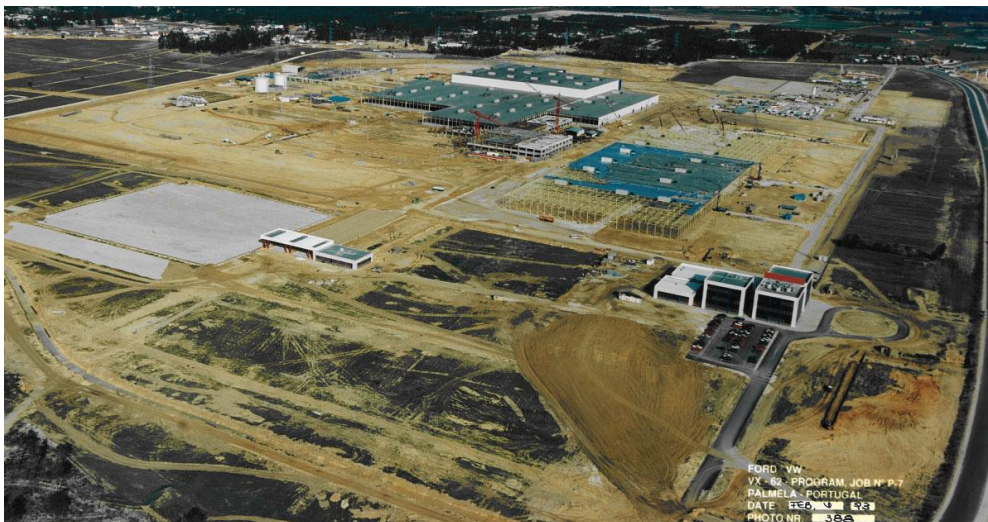
Figura 2 - Construção da Fábrica Volkswagen Autoeuropa - 1991 [2]
