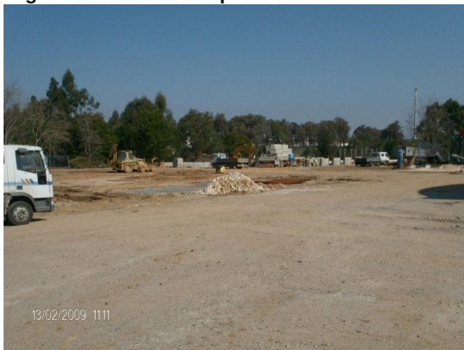
Figura 12- Obras no BApSvc
