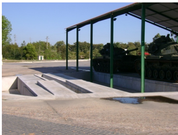
Figura 11- Fossas de Lubrificação
