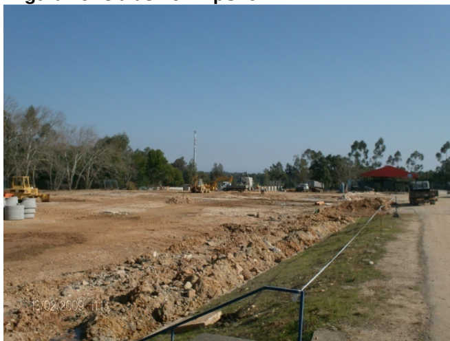
Figura 13- Obras no BApSvc
