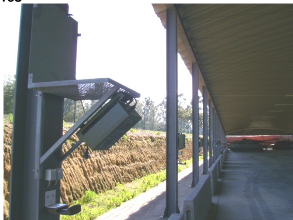
Figura 21- Pré-instalação dos desumidificadores
