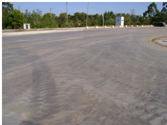
Figura 9- Piso do GCC reforçado e impermeabilizado
