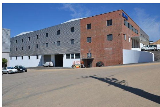
Figura 3.3 - Unidade Produtiva de Serpins - Edifício 3.
