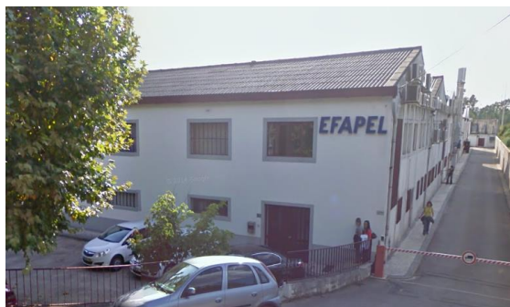
Figura 3.1 - Unidade Produtiva de Serpins - Edifício 1.
