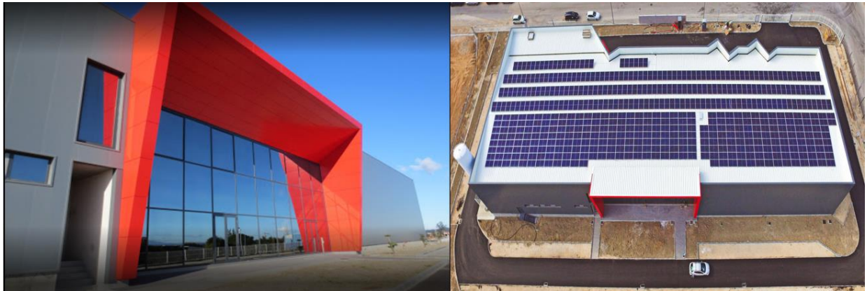
Figura 1 - Instalações da empresa Friquental .
