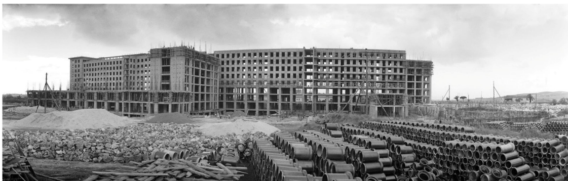
Figura 11 - Vista do Hospital de Santa Maria durante a sua construção
