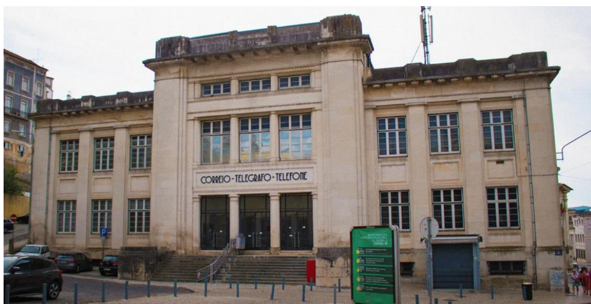
Figura 3.8 – Edifício dos Correios, Telégrafos e Telefones, em Coimbra, alvo de requalificação.
