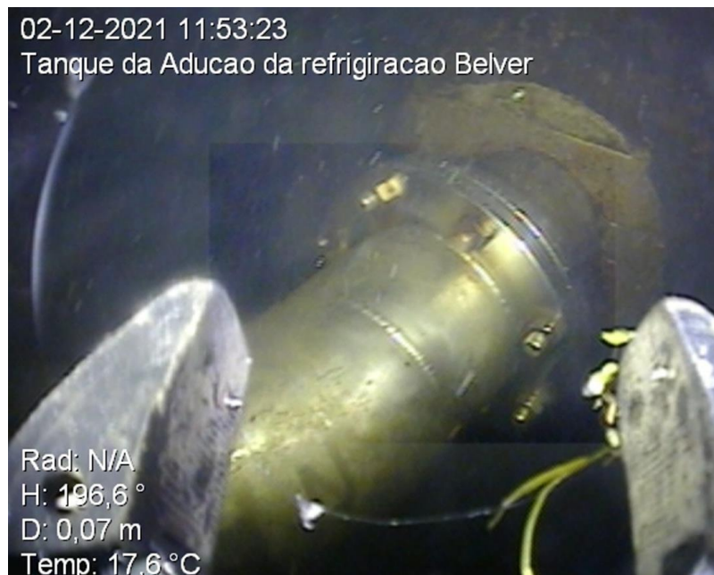
Figura 22 - Inspeção subaquática com ROV
