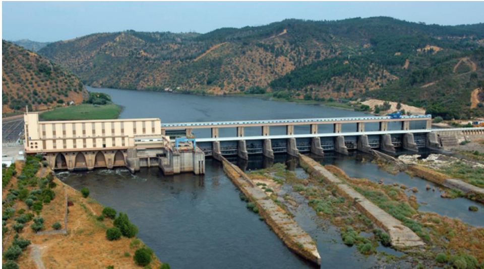
Figura 18 - Aproveitamento Hidroelétrico de Belver.
