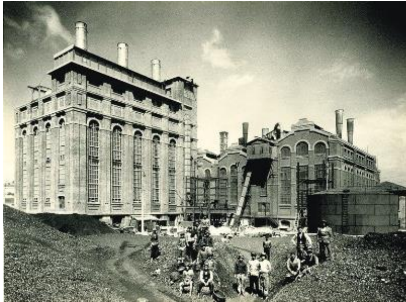
Figura 30 - Anexo I - Central termoelétrica EDP
