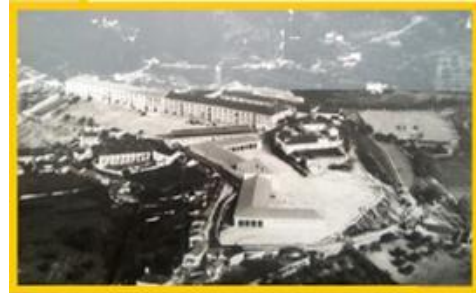
Figura 19 - Instalações da EPC em Torres Novas (1940) Fonte: www.exercito.pt
