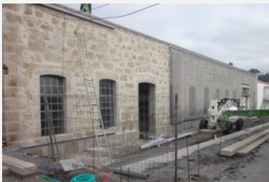
Fig. 24 Colocación de rejilla. Fotografía de autor.
