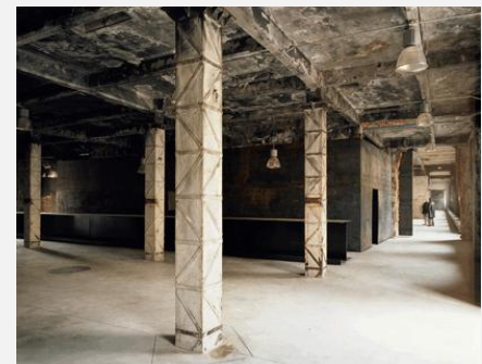
Fig. 98 Interior. Fotografía sacada de www.intermediae.es
