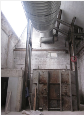
Fig. 140 Conservación del horno y vista de los tubos de infraestructuras. Fotografía de autor.
