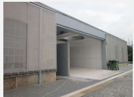
Fig. 15 Nueva abertura en fachada para calle interior. Fotografía de autor.
