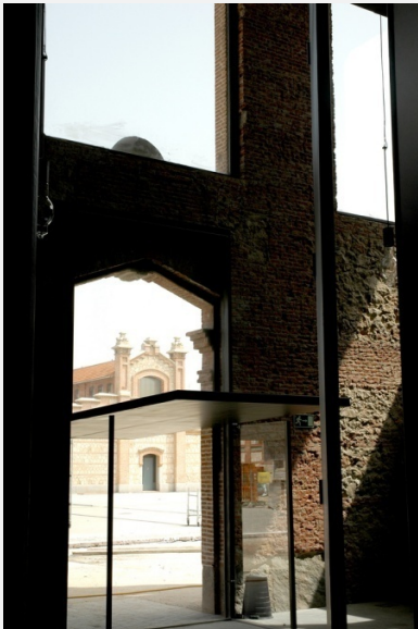
Fig. 86 Acceso principal. Fotografía sacada del perfil de Flickr de Matadero Madrid.
