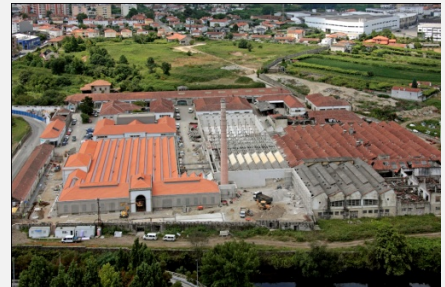
Fig. 20 Vista de la calle interna descubierta y la plaza multimedia en construcción. Fotografía de Francisco Piqueiro.
