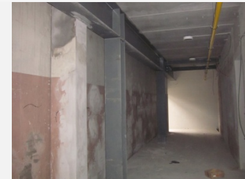
Fig. 139 Refuerzo de la estructura existente. Fotografía de autor.
