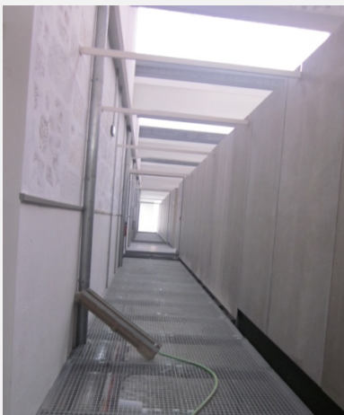
Fig. 27 Trasera del cubículo de la calle interna cubierta. Fotografía de autor.
