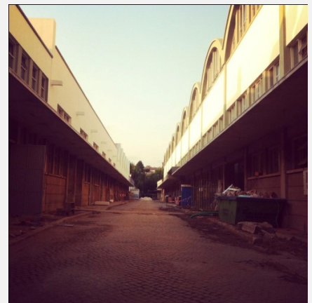
Fig. 112 Vista de los dos pabellones
