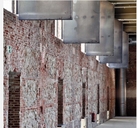
Fig. 80 Paredes de la nave. Fotografía sacada del perfil de Flickr de Matadero Madrid
