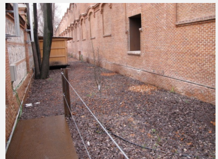
Fig. 103 Espacio Avant Garden sin intervenir. Fotografía sacada del perfil de Flickr de Intemediae
