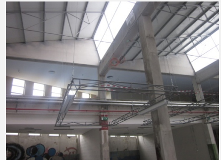
Fig. 131 Estructura metálica de infraestructuras de la Incubadora.
