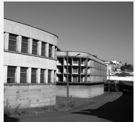
Fig. 126 Entrada a los pabellones desde Rúa da Fundição. (OLIVEIRA, pág.66)
