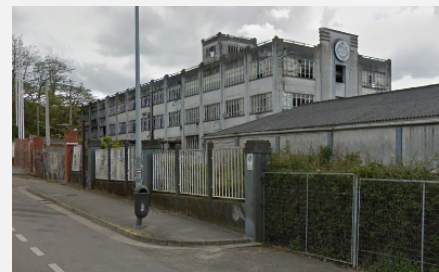
Fig. 153 Fotografía desde la Avenida de Ramón Nleto. Fotografía de autor.
