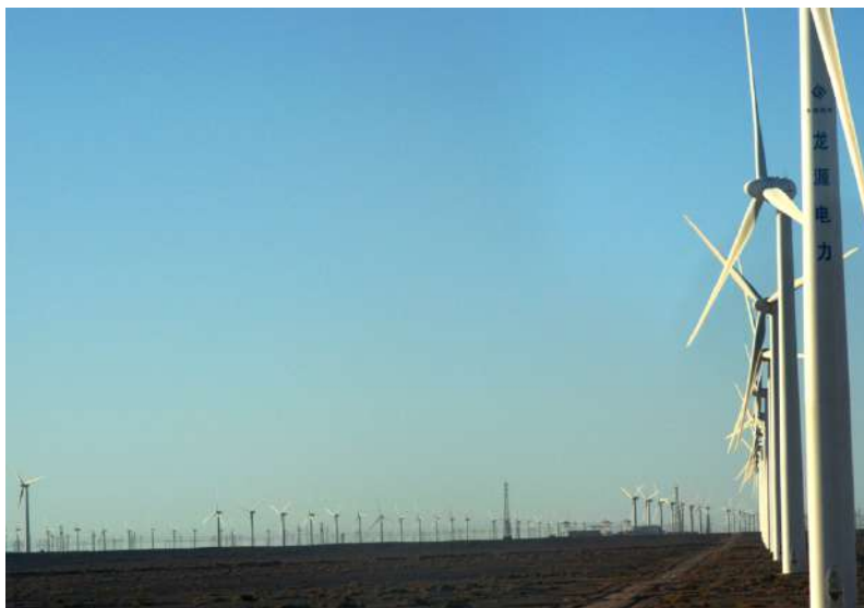
Figura 19 - Parque Eólico de Gansu, China.
