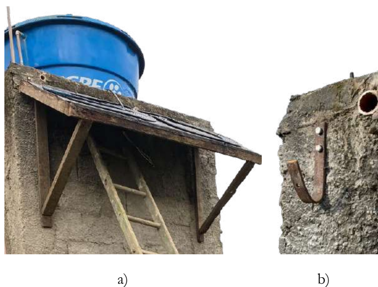
Figura 61 - Fixação do projeto a estrutura da caixa d'água: a) Conjunto preso aos ganchos; b) Gancho de aço preso ao pilar da estrutura.
