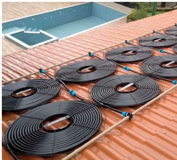
Figura 49 - Disco coletor do tipo aquecimento de piscinas
