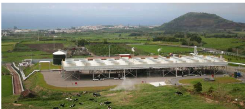
Figura 23 - Central Geotérmica do Pico Vermelho.
