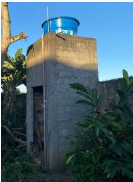
Figura 50 - Estrutura que suporta a caixa d'água.
