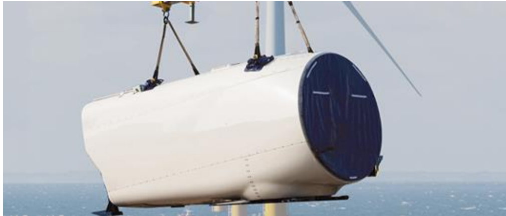
Figura 27 - Cabina ou Nacelle (offshore wind, 12)
