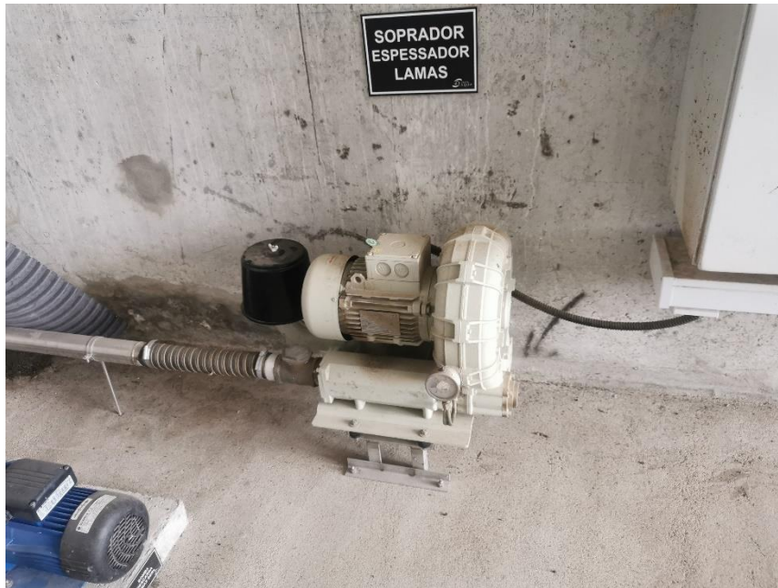
Figura 21 - Soprador do Espessador
