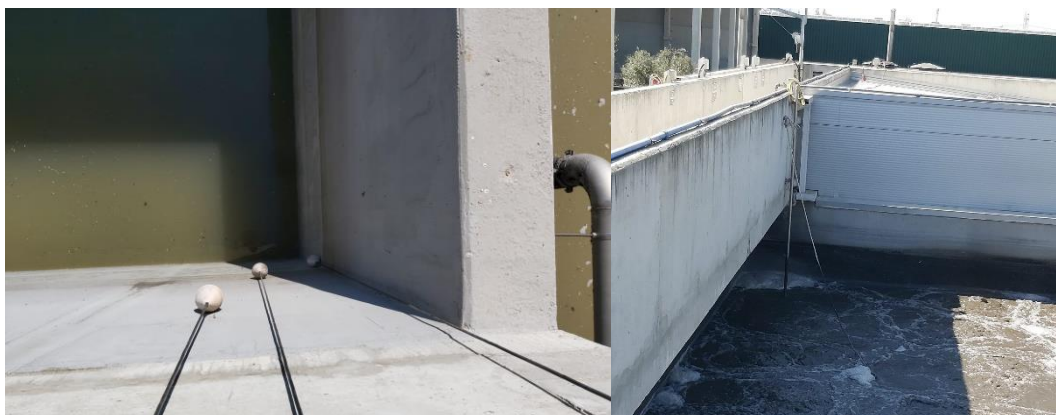
Figura 28 - Bóias de nível (à esquerda) e nível hidrostático (à direita)
