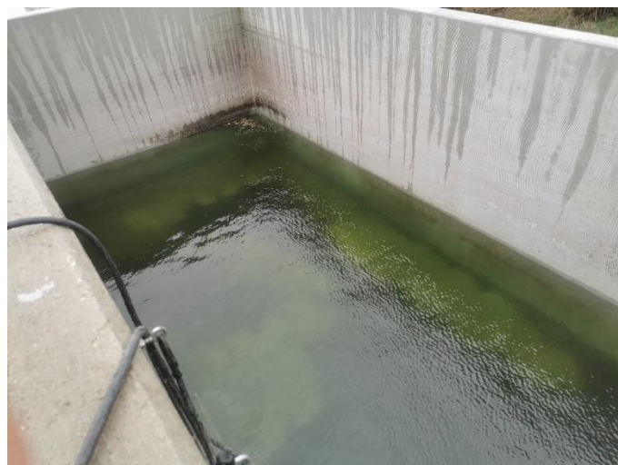
Figura 17 - Tanque de Saída da água tratada
