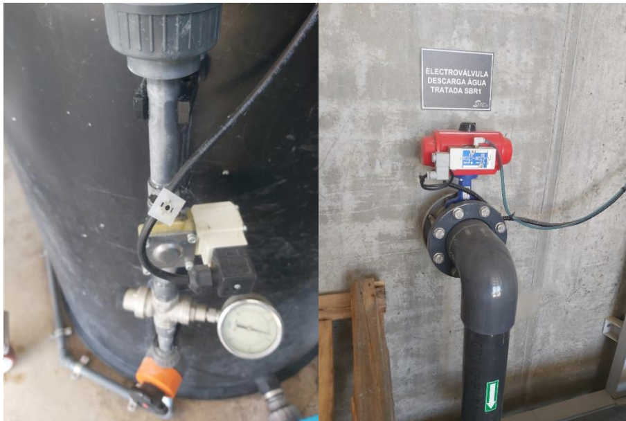
Figura 30 - Electroválvula pequena do preparador do floculante (à esquerda) e electroválvula grande da descarga do SBR1 (à direita)
