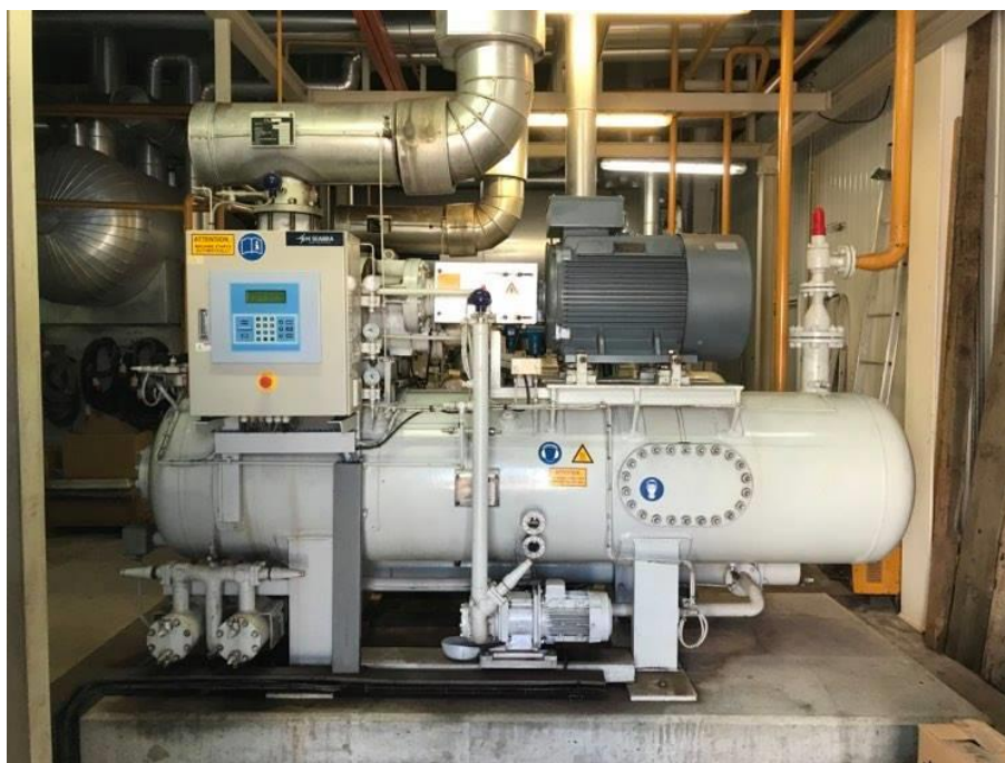
Figura 8 – Exemplo de um compressor de parafuso (Cofisa 2)
