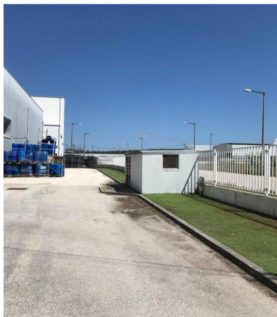
Figura 26 - Vista exterior após o encaminhamento dos resíduos (Cofisa2)
