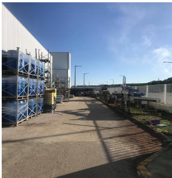
Figura 25 – Vista exterior antes do encaminhamento dos resíduos (Cofisa2)
