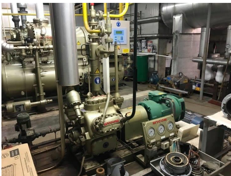
Figura 7 – Exemplo de um compressor alternativo (Cofisa 2)
