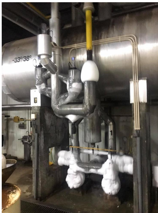
Figura 11 - Separador de líquido (Cofisa 2)
