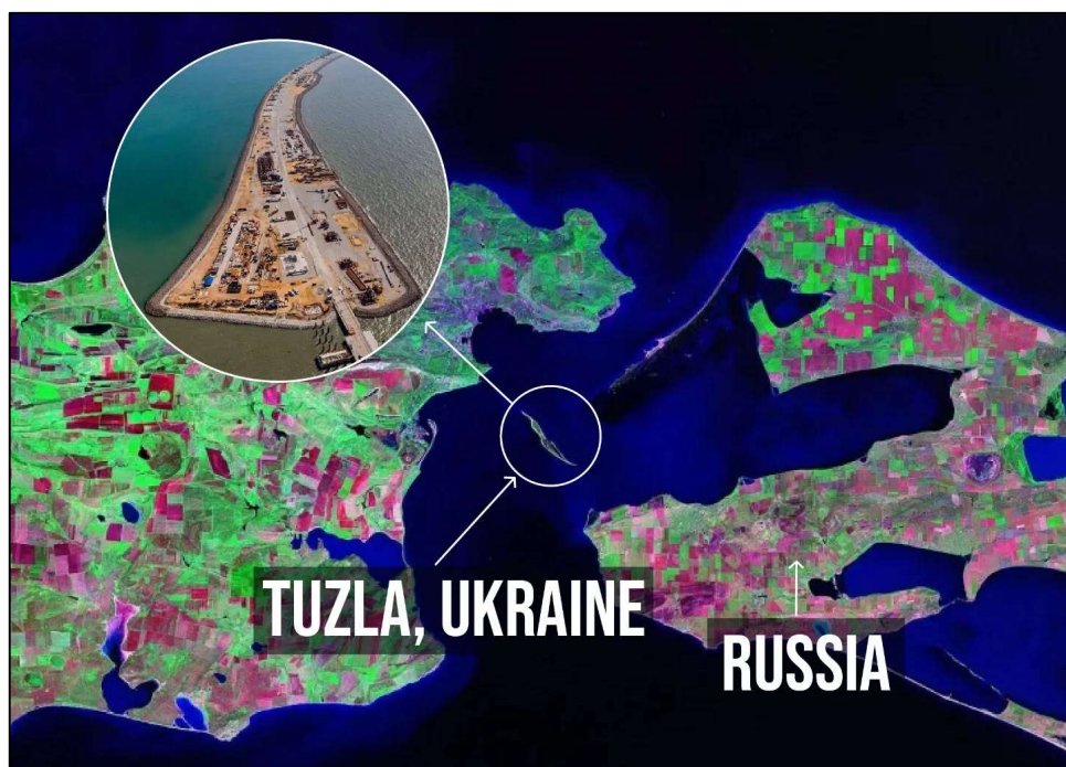
Figura 8 - Localização da Ilha de Tuzla e dique construído em 2003
