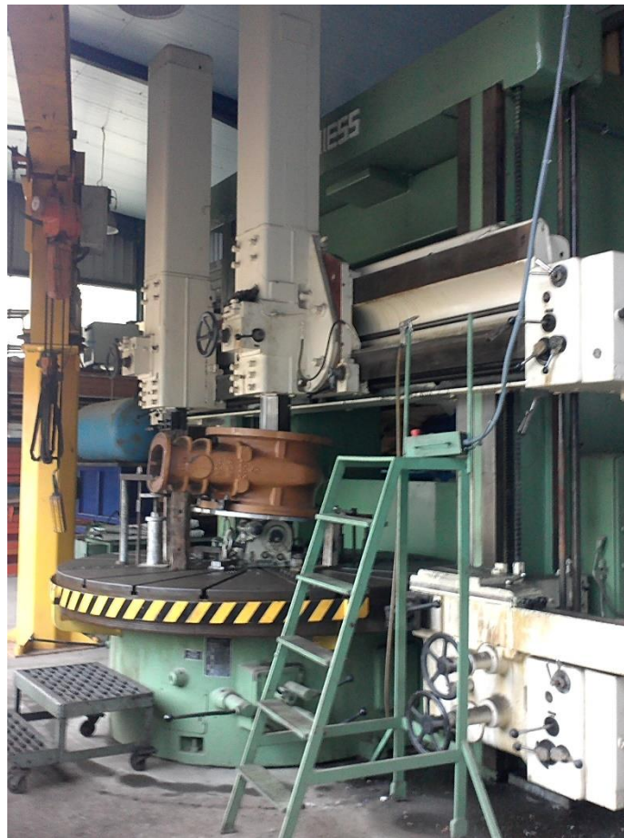
Figura 4 – Reparação de Válvula de cunha
