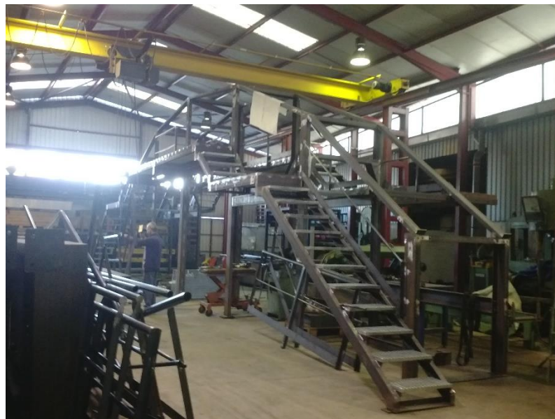
Figura 2 – Construção de estrutura
