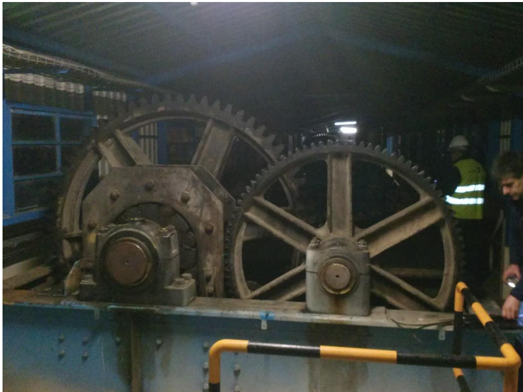
Figura 87 – Campanha de análise e medições dos 10 grupos de engrenagens de acionamento das comportas da Barragem Hidroelétrica de Belver (EDP)
