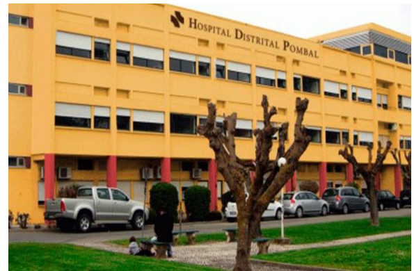
Figura 2.2 Hospital Distrital de Pombal, Pombal
