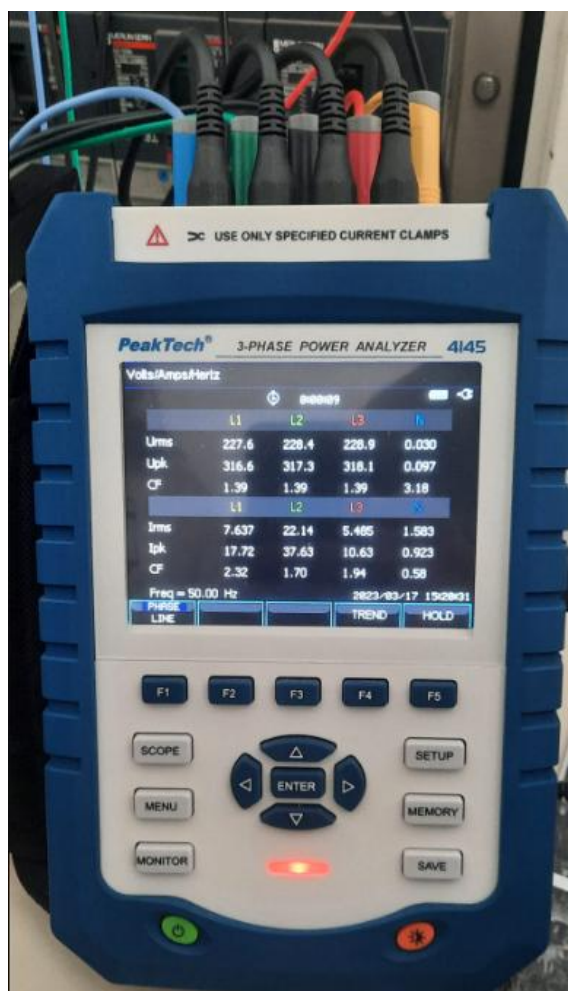
Figura 3.17 – Analisador de energia trifásico da marca PeakTech .
