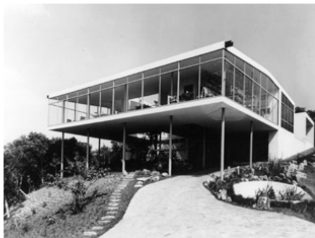
46. Casa de Vidro de Lina Bo Bardi, 1951.
