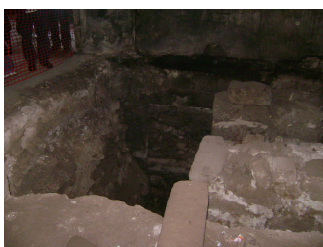
Fig. 3 e 4 - Inspeções realizadas num edifício antigo na zona da Bainharia, no Centro Histórico do Porto (registo da autora).
