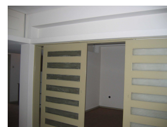
Fig. 125 - Preexistente - sala de estar e sala de jantar (Mário Azevedo, 2007).
