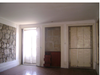
Fig.139 - Existente - piso 1, frente de rio (registo da autora).
