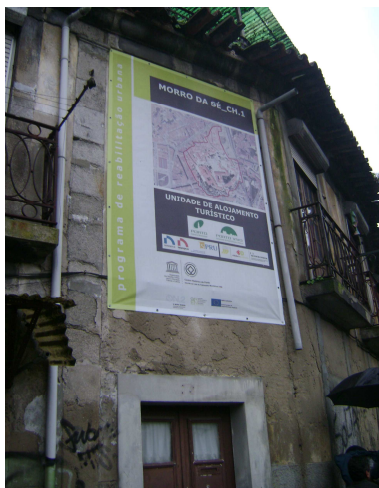
Fig. 67 (esq.) - Operação de reabilitação levada a cabo pela Porto Vivo, SRU - Morro da Sé (registro da autora).
