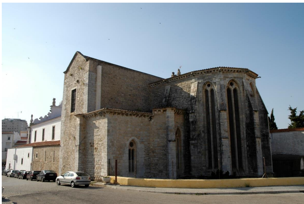
Fig. 10 – Igreja de São Domingos de Elvas, Cabeceira
