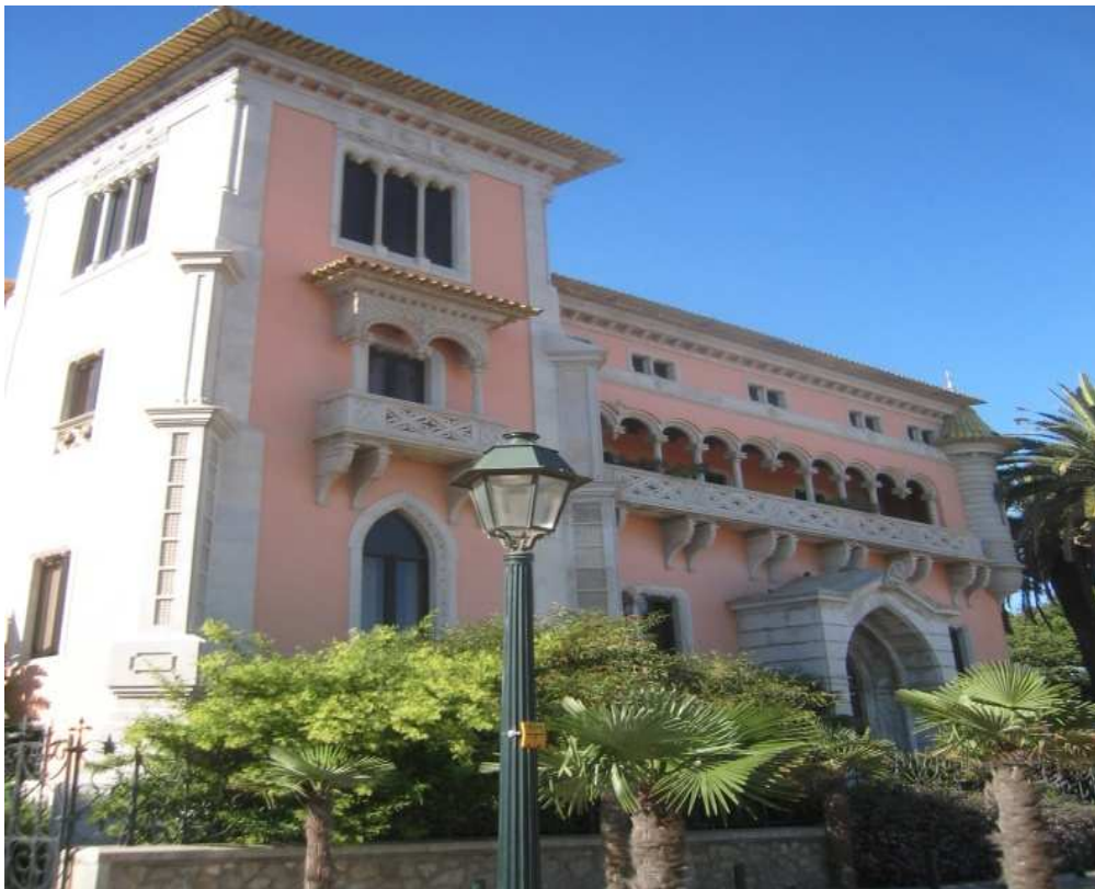
Casa D. António Lencastre – Fachada Sul e Torreão – Albatroz Palace.
