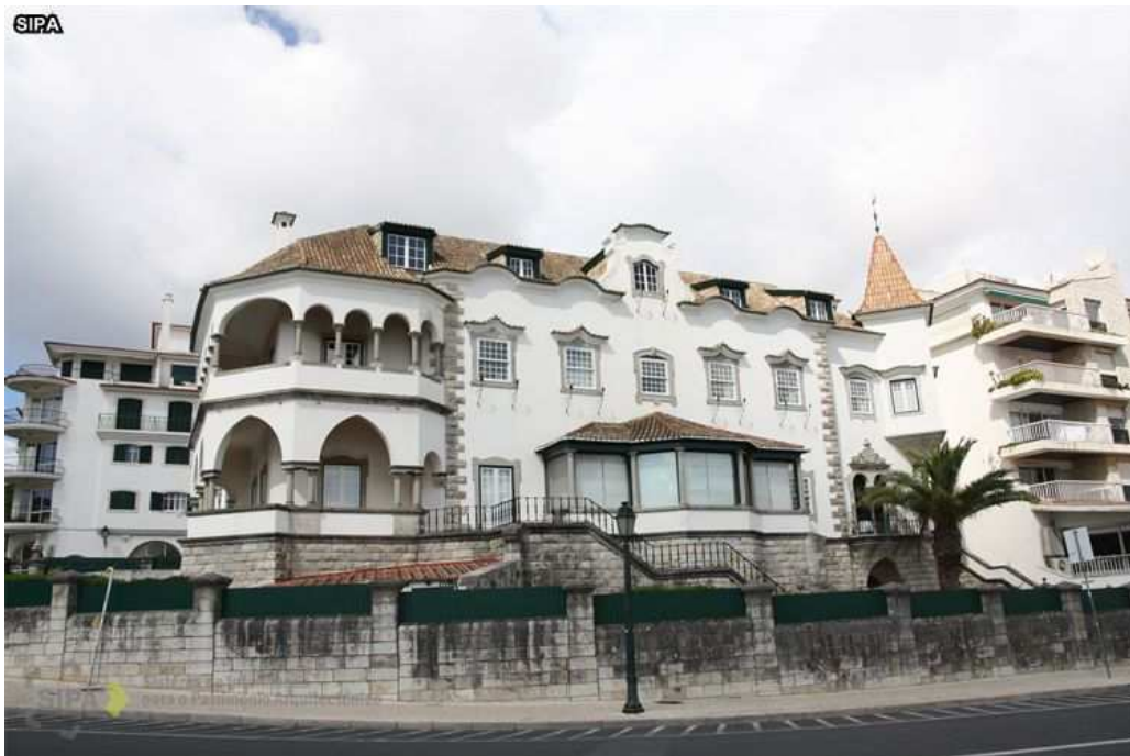
Casa Conde Monte Real – Alçado Nascente.
