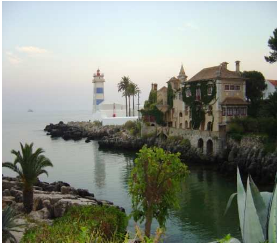
Casa de Santa Maria – Alçado Nascente e Forte e Farol de Santa Marta
