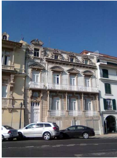
Casa Luís Augusto Perestrelo de Vasconcelos.
