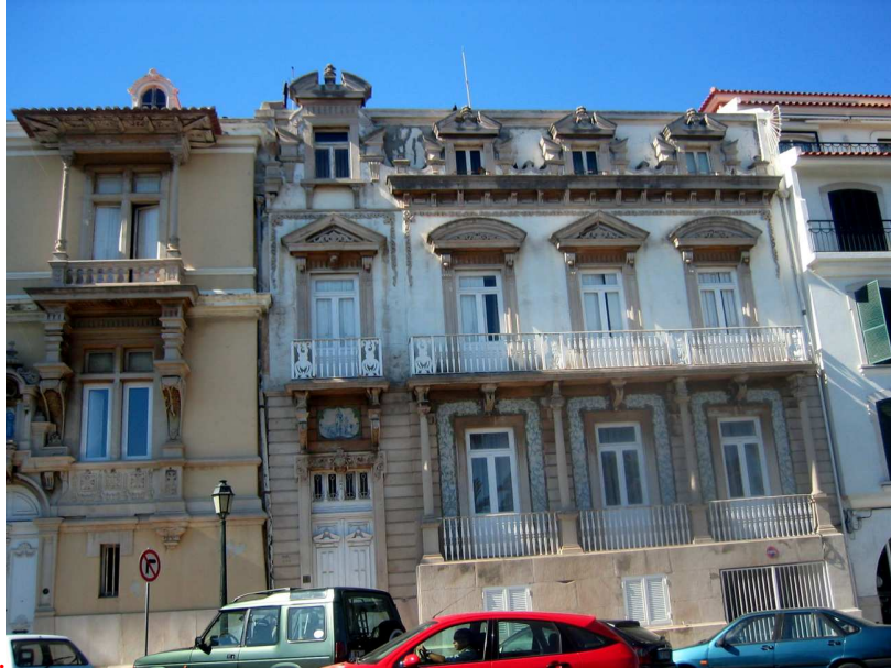
Casa Luís Augusto Perestrelo de Vasconcelos.
