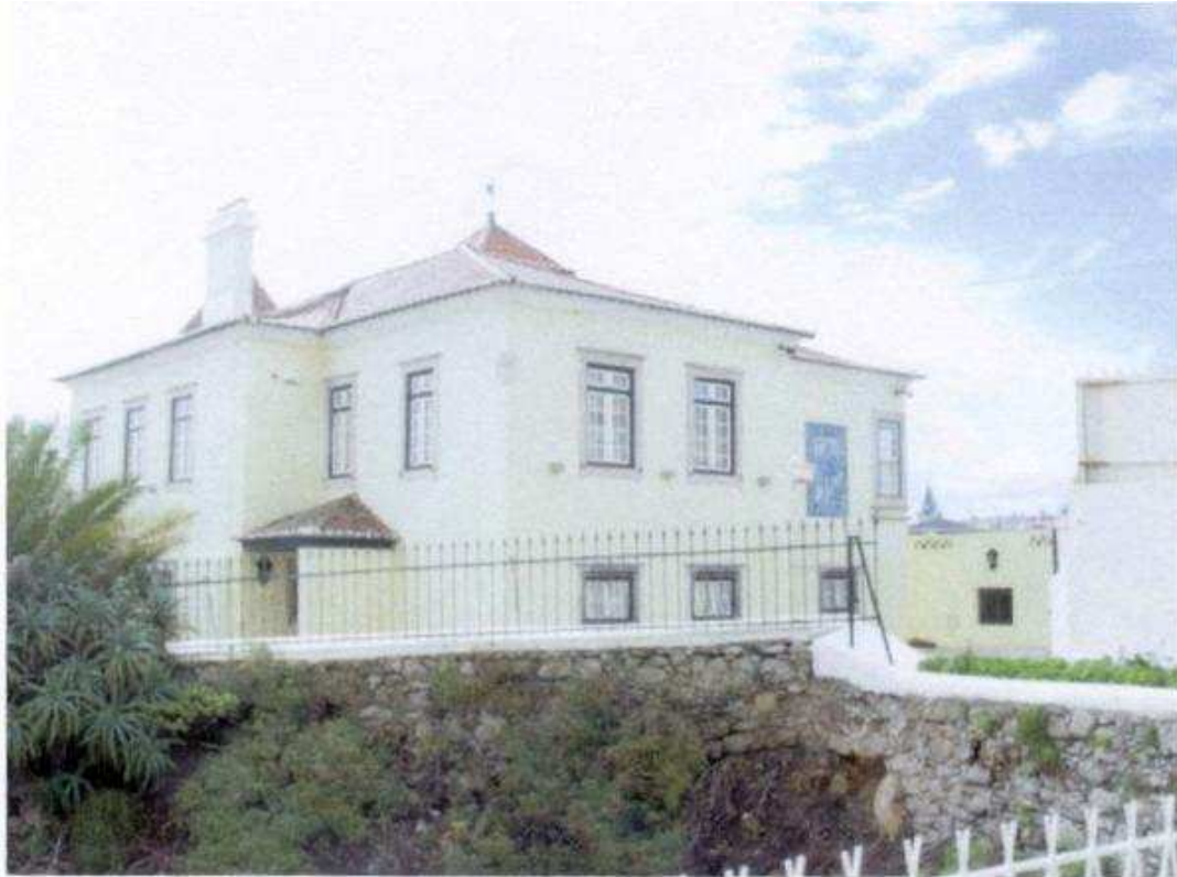
Casa dos Almadas – Vista geral.
