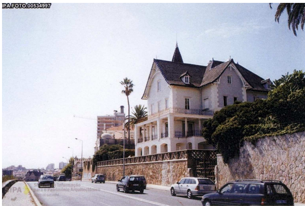
Chalet da Rainha D. Maria Pia – Alçada Sul e Nascente.
