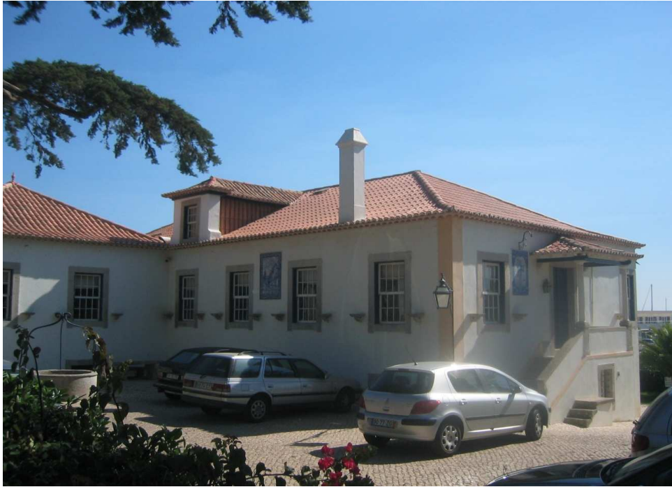
Casa de S. Bernardo – Fachada Norte.
