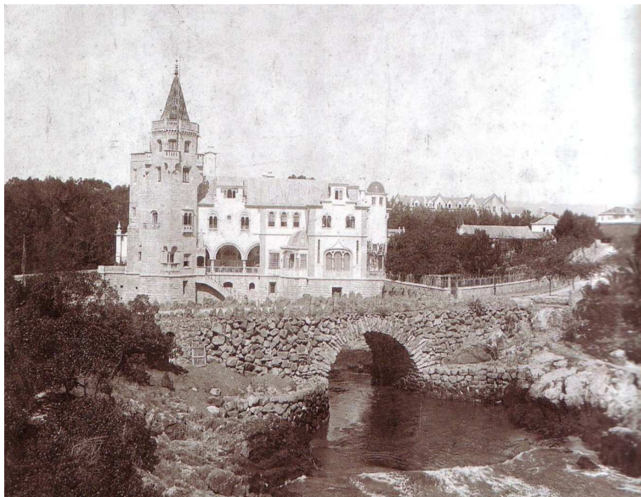
Palácio O'Neill/Condes de Castro Guimarães (1900) – Francisco Vilaça – Fachada Sul.
