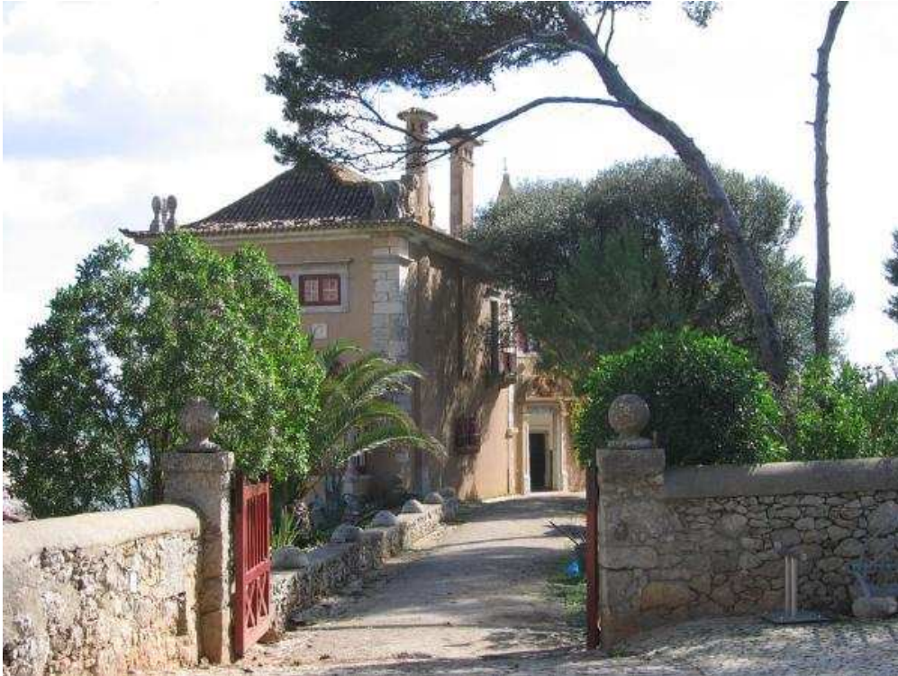
Casa de Santa Maria – Fachada Norte, portão de entrada e pórtico principal de entrada.
