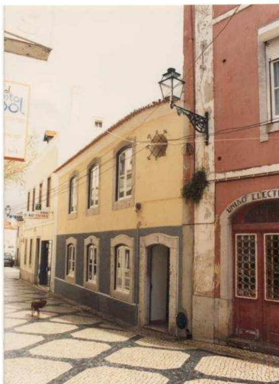
Antigo edifício dos Paços do Concelho – Cascais – Fachada Poente.
