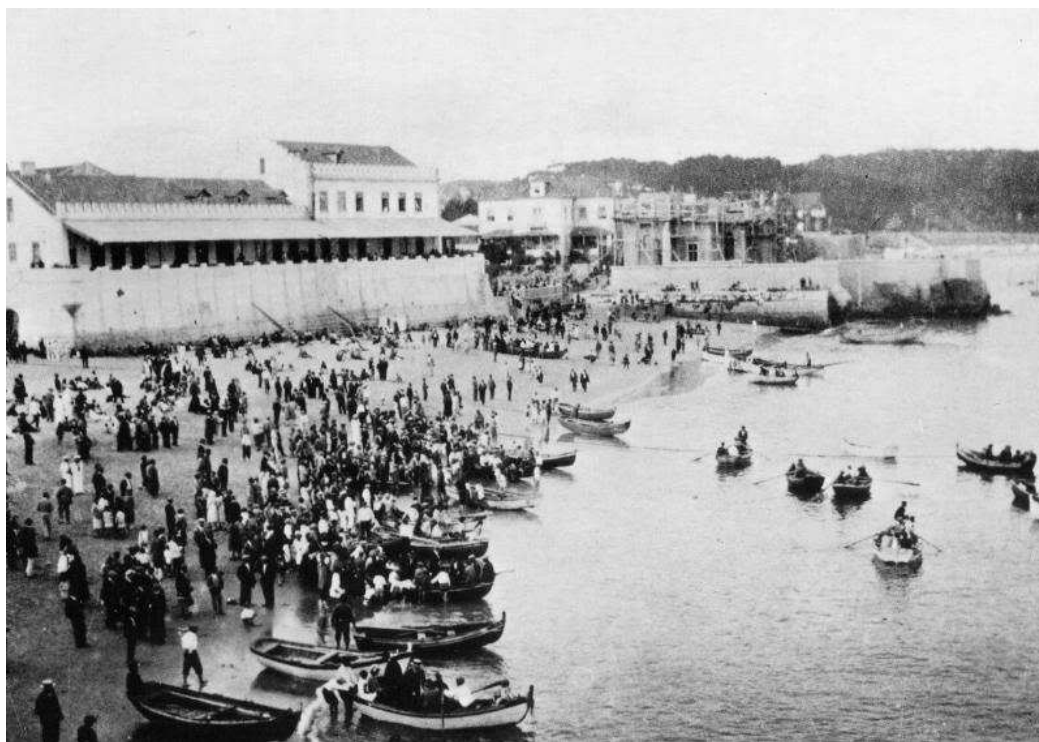
Palácio Seixas em construção.
