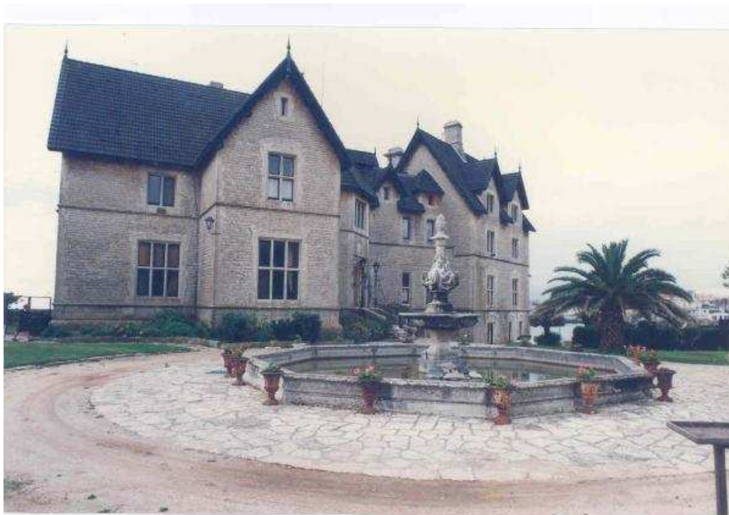
Palácio Palmela – Fachada Norte.
