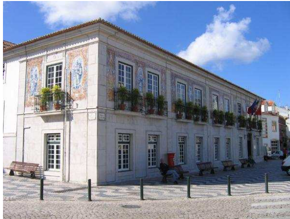
Casa dos Condes da Guarda
