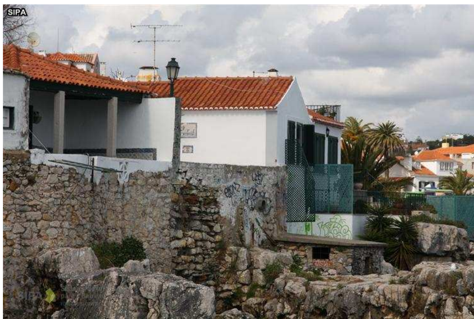
Cascais - Cortina de Atiradores.
