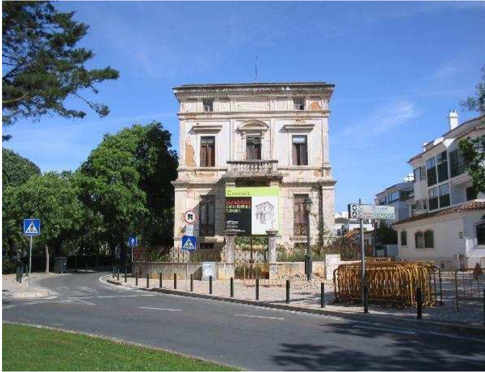
Casa Sommer – Vista geral do edifício e sua integração na malha urbana.
