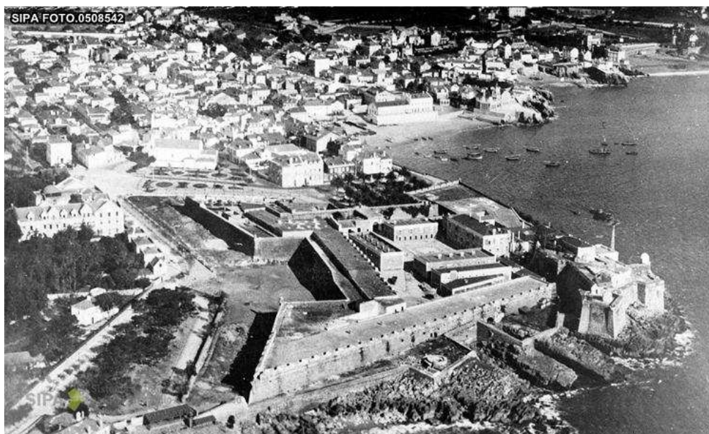
Cidadela de Cascais – Vista aérea (lado Ocidental).
