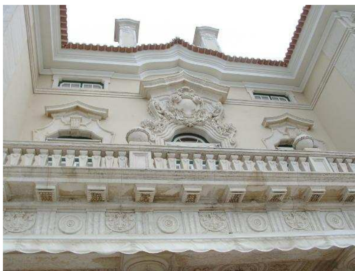
Casa de São Cristóvão – Fachada principal.
