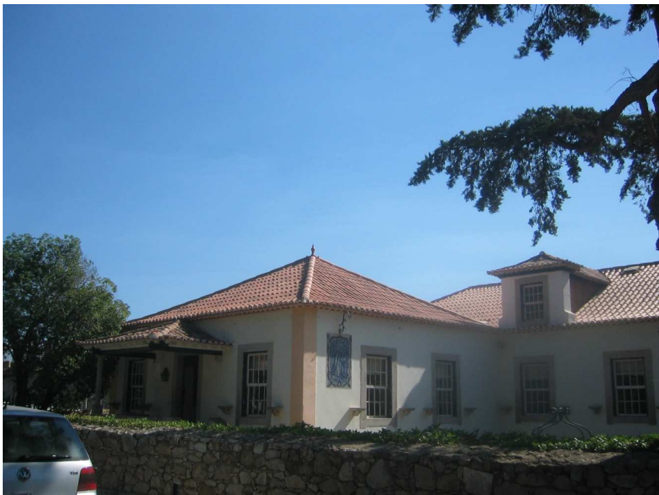
Casa de S. Bernardo – Fachada Norte.
