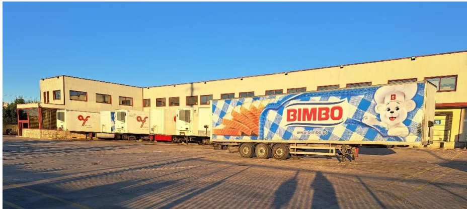
Figura 6. Fábrica Bimbo de Albergaria-a-Velha.
