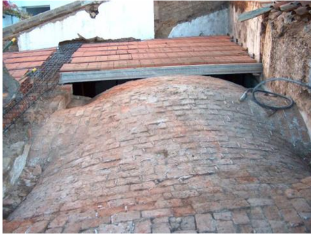
Ilustração 1: Confronto de sistemas estruturais: Não tradicional (em cima); Tradicional (em baixo).
