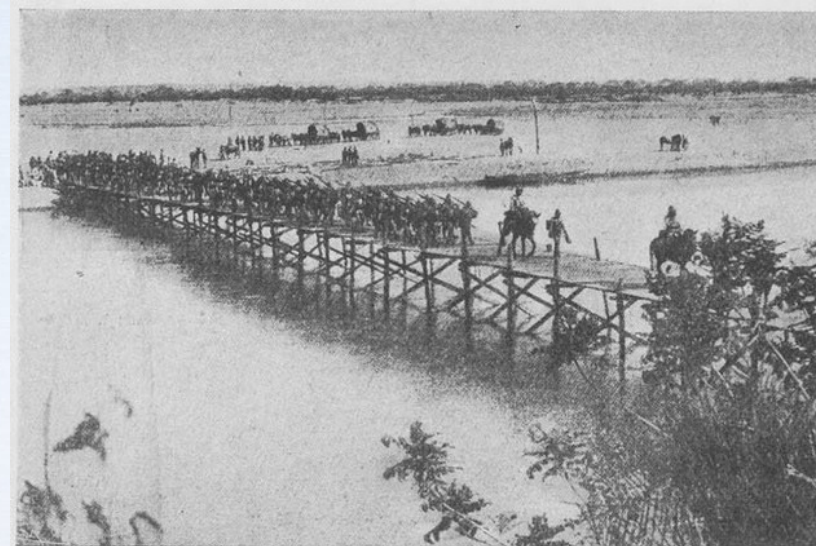
Travessia do Rovuma: Ponte de Cavaletes.
