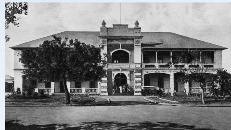
Hospital Miguel Bombarda em Lourenço Marques (1914), Edifício Central
