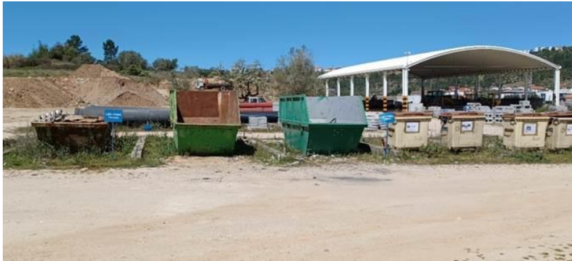
Figura 19- Zona de armazenamento temporário de resíduos produzidos nas obras internas da AC.
