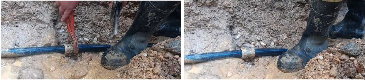
Figura 10 – Reparação de uma rotura de água num ramal domiciliário.
