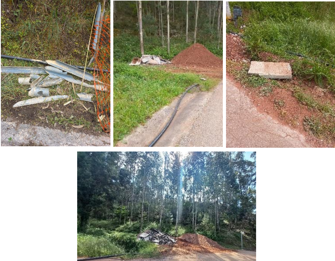
Figura 15- RCD depositados em vários pontos da frente de serviço
