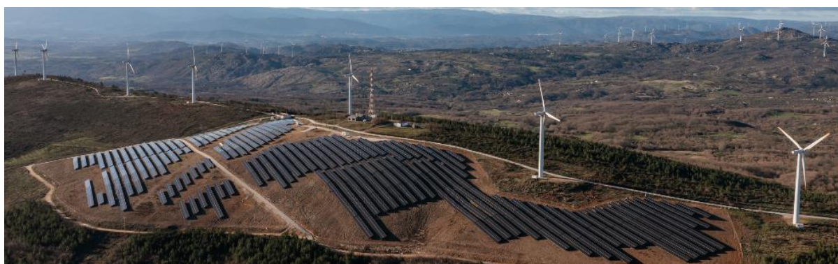
Figura 77: Vista Geral - parque híbrido solar e eólico (Minas Orgueirel – Sabugal)
