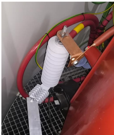
Figura 103: Instalação de descarregador de sobretensão MT
