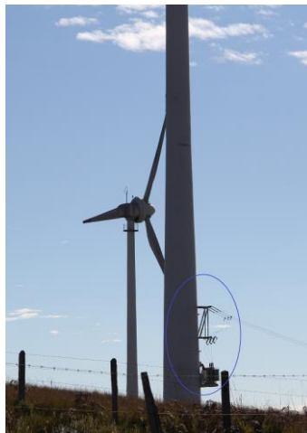
Figura 88: Aerogerador com transformador no exterior da torre
