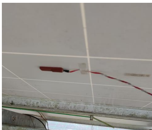
Figura 53: Sensor de Temperatura de Módulos Solares
