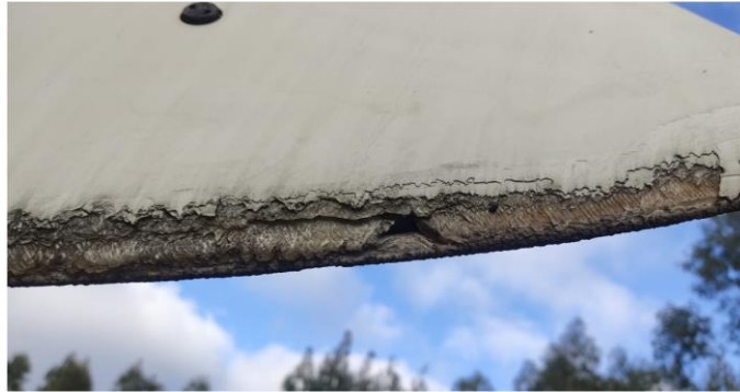
Figura 6: Pormenor de uma pá com erosão no bordo de fuga
