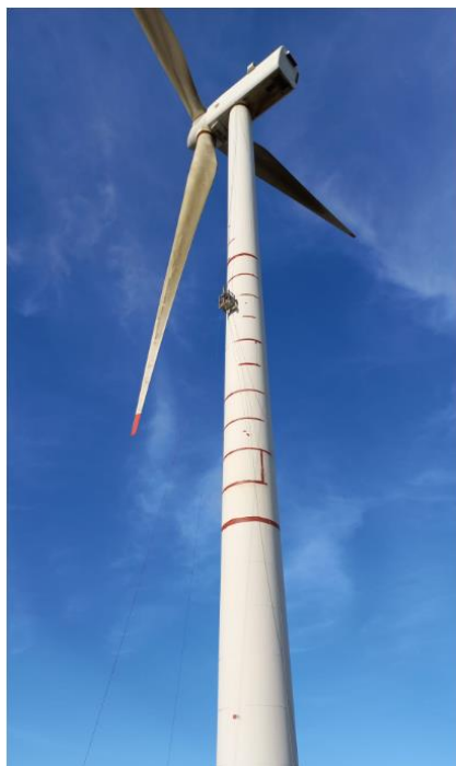
Figura 7: Reparação da pintura numa torre aço
