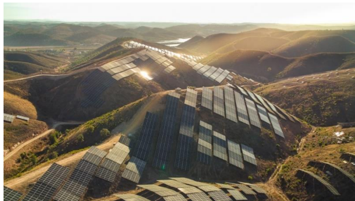
Figura 42: Parque Fotovoltaico Seguindo a Orografia do Terreno [12]
