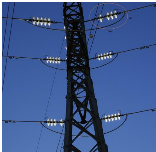
Figura 94: Isolador com um disco partido – LAAT
