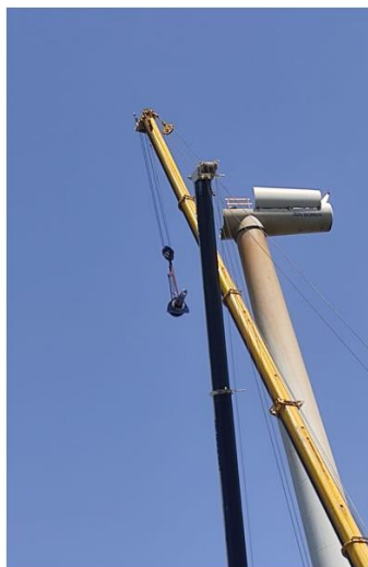
Figura 24: Substituição da caixa multiplicadora e veio principal
