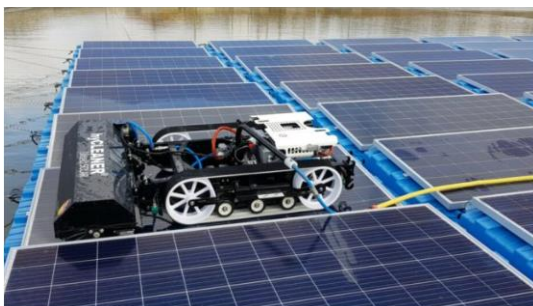
Figura 79: Limpeza de módulos fotovoltaicos - parque flutuante [22]
