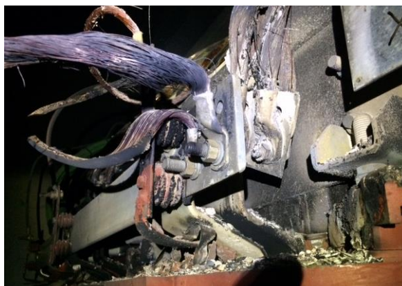
Figura 18: Transformador danificado
