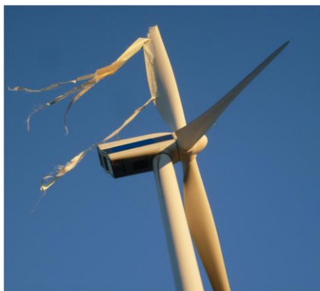
Figura 19: Aerogerador com a pá danificada
