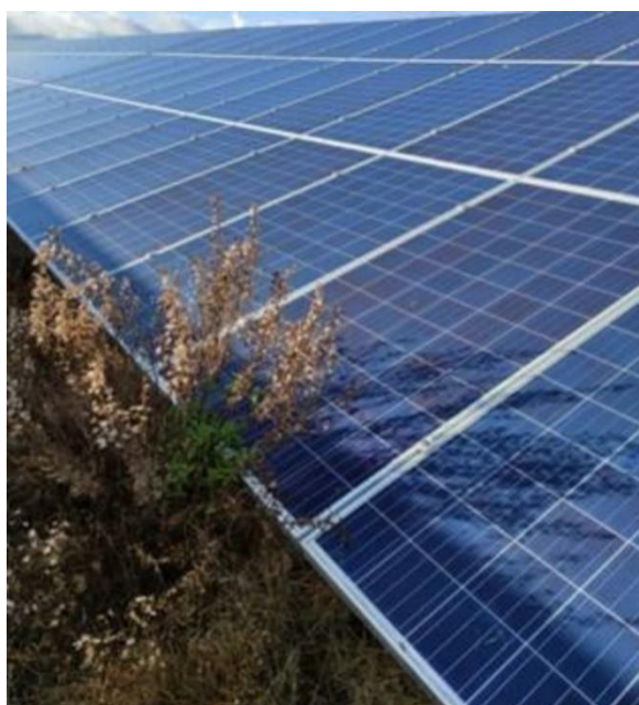
Figura 113: Sombreamento devido à vegetação e estrutura da frente
