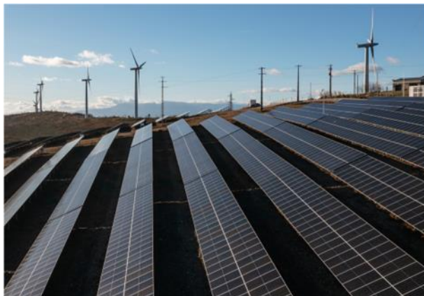
Figura 78: Parque Híbrido (Solar e Eólico)
