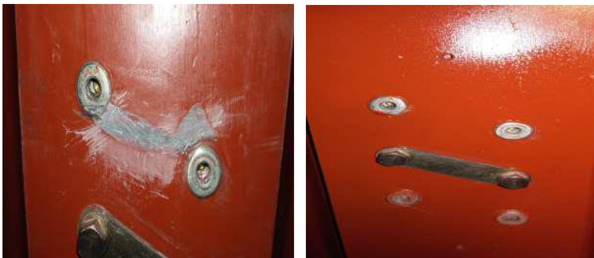
Figura 106: Reparação de fissuras
