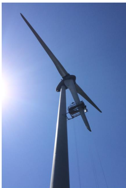
Figura 5: Manutenção e reparação das pás com plataforma suspensa
