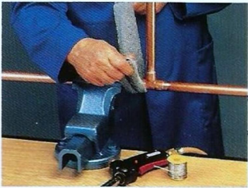
10. Arrefecimento e limpeza final
