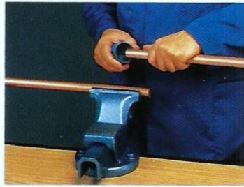
2. Eliminação das rebarbas interiores e exteriores
