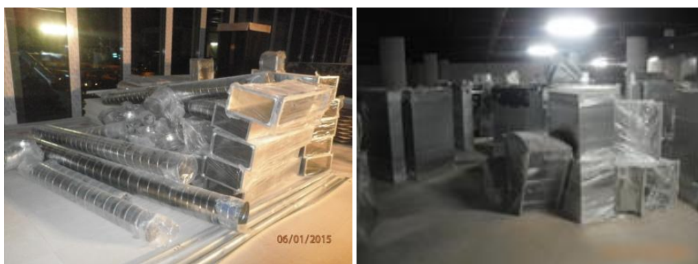
Figura 5.29 – Armazenamento adequado dos elementos de AVAC, em fase de obra, com proteção que visa evitar a sua contaminação, durante a realização dos trabalhos.
