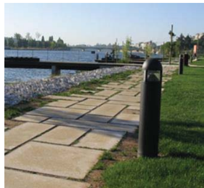
Figura 16: iluminação do percurso do Parque do Mondego por balizadores com proteção antifurto e design adequado. Fonte: Euro Acessibilidade (2014). 13
