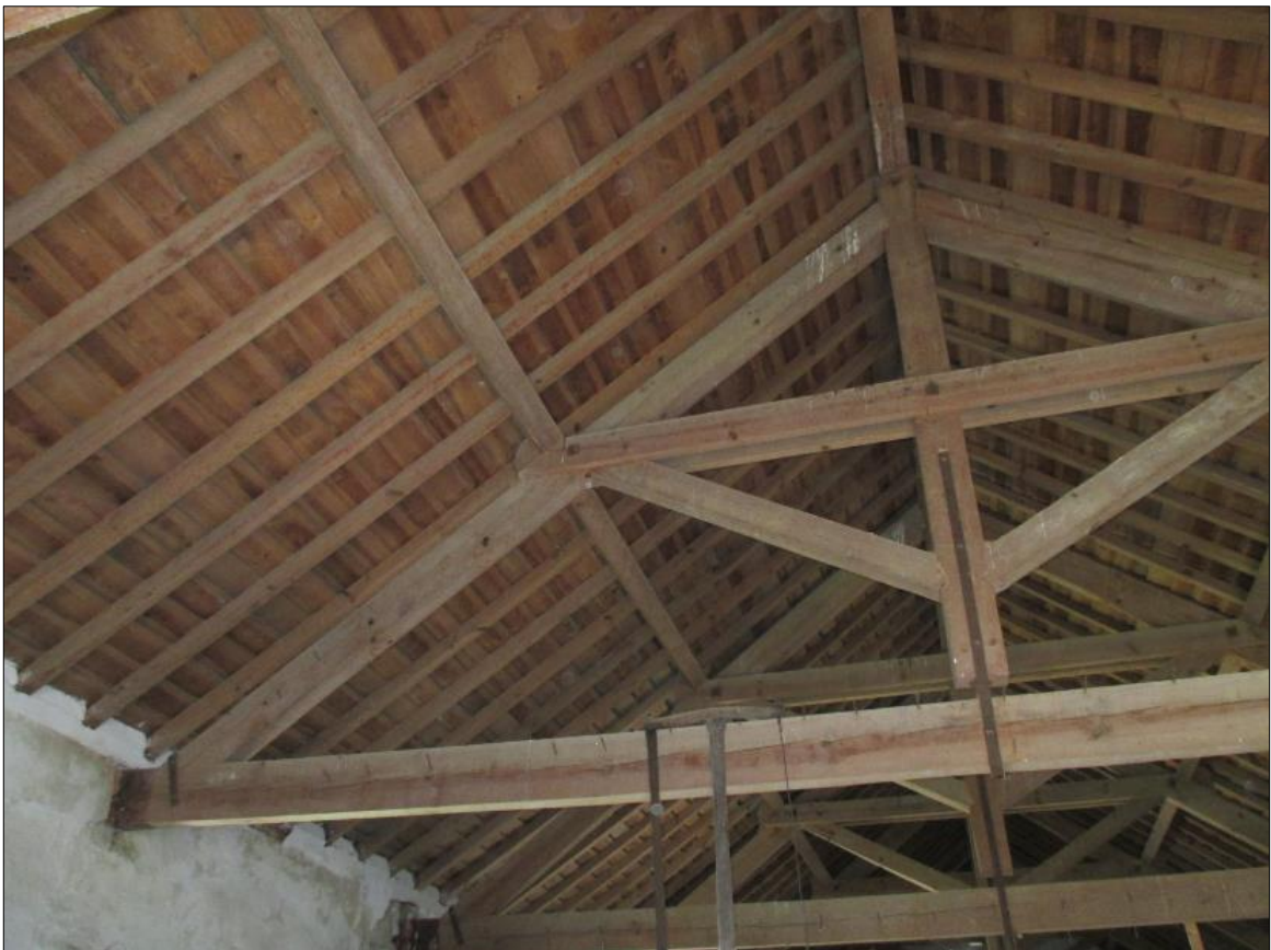
Figura 54 – Asna simples com contra - linha. [TIAGO, P.M. 2014];
