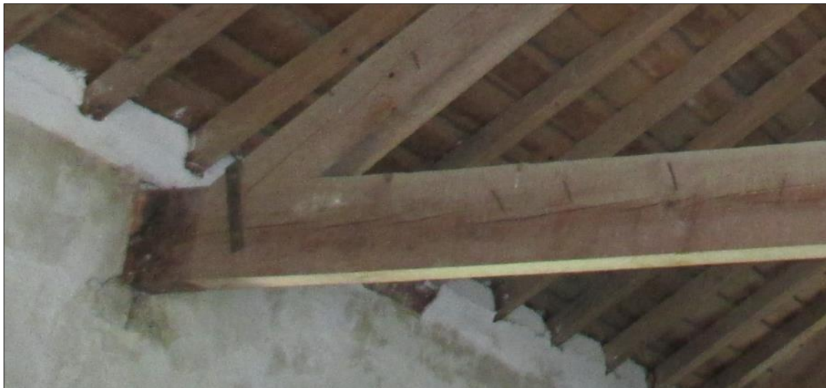
Figura 32 – Linha de asna com alto teor em água. [TIAGO, P.M. 2014];
