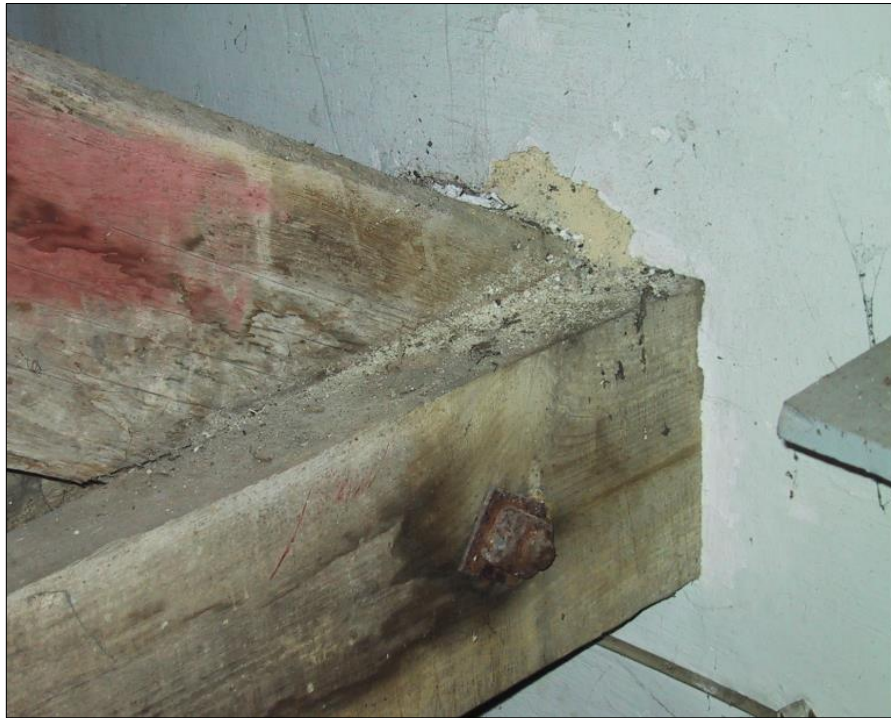
Figura 44 – Ligação por parafuso. [TIAGO, P.M. 2014];
