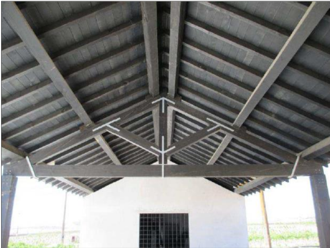
Figura 35 – Asna de cobertura simples em obra. [TIAGO, P.M. 2014];
