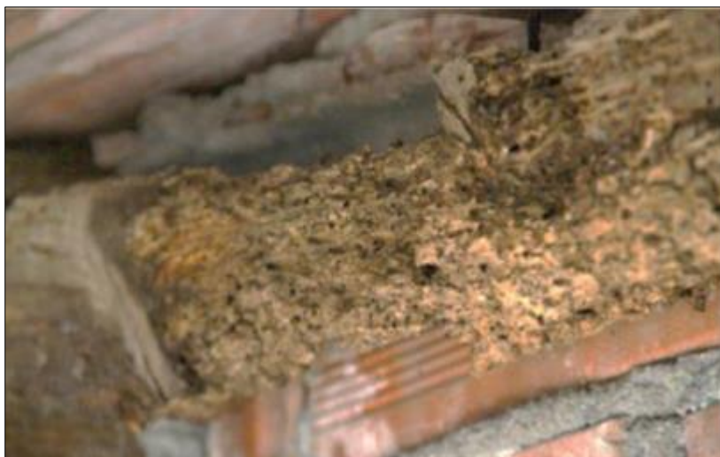
Figura 30 – Madeira atacada por caruncho.[CORREIA, A.M. 2014];
