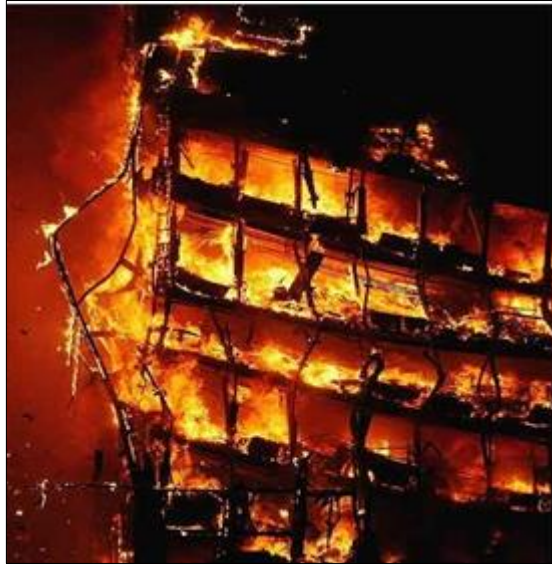
Figura 33 – Edifício em chamas, completamente destruído. [CORREIA, A.M. 2014];
