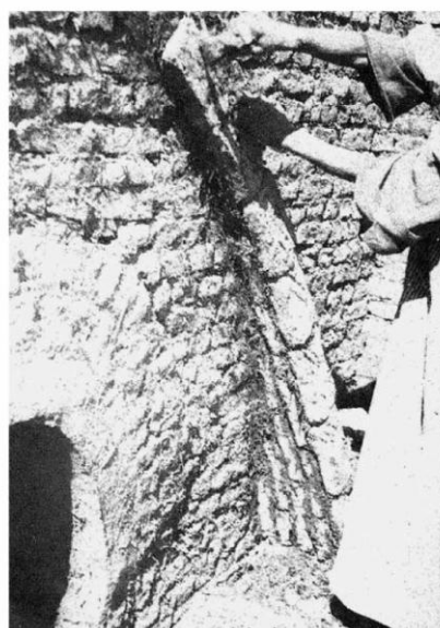
Fig. 27. Los peones construyen gradualmente la hilada inclinada.
