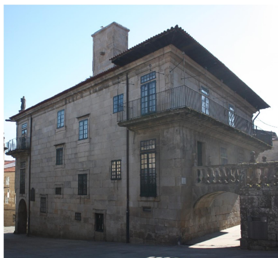
Fig. 75 Alzado oeste con el puente de nueva construcción
