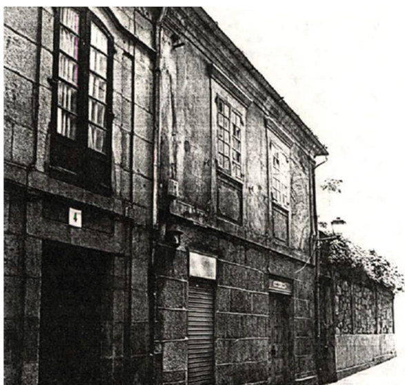
Fig. 95 Viviendas nº 2 y 4 antes de la reforma
