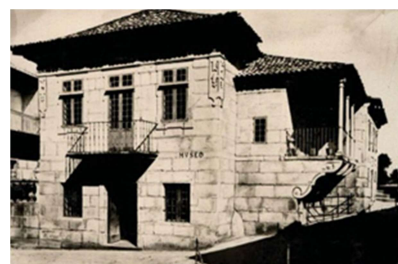
Fig. 43 Edificio Castro Monteagudo
