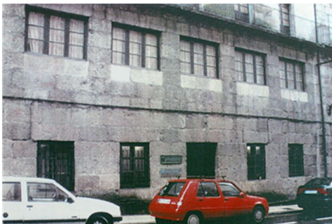
Fig. 135 Fachada del edificio con la ampliación de la planta primera
