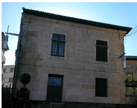
Fig. 49 Reforma vivienda anexa en 1936
