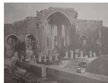
Fig. 5 Ruinas de Santo Domingo
