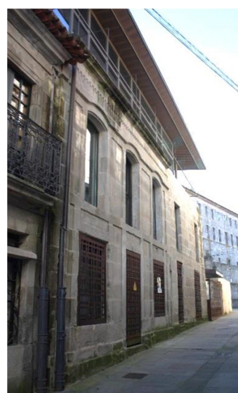
Fig. 96 Edificio después de la reforma
