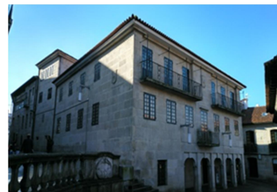
Fig. 86 Fachada edificio Fernández López
