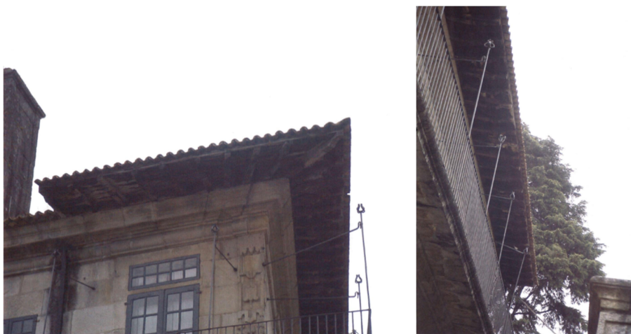
Fotografías de proyecto sobre cambio de cubierta en el edificio García Flórez
