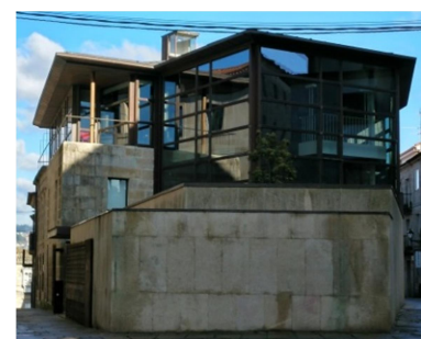
Fig. 90 Ampliación del edificio
