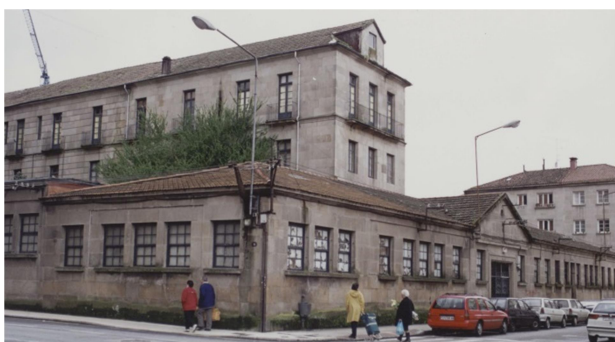
Fig. 119 Edificio del Hogar Provincial antes de su demolición
