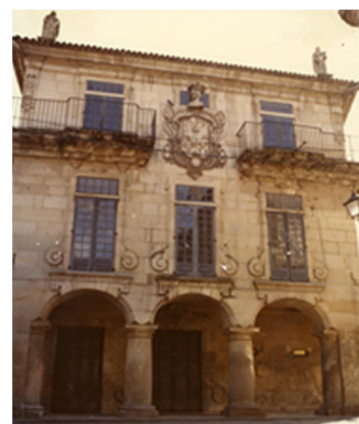
Fig. 71 Fachada principal del edificio
