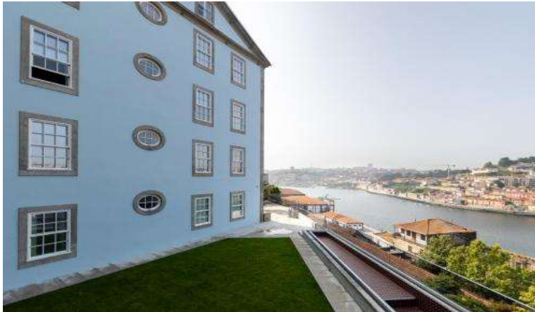
Figura 15 - Guest House de luxo Maison Bleue
