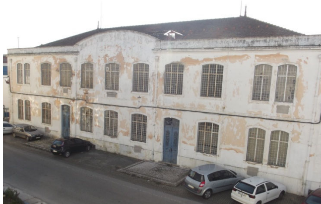
Ilustração 18: Edifício do antigo Escritório Principal da MDF.
