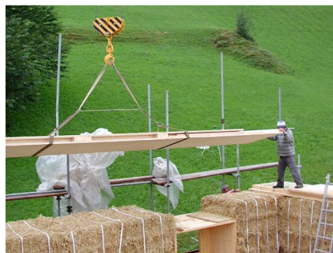
Figura 26. Muro Portante, Acrobax Librería y Sala de Conciertos, Rome, Italy, 2013 (European Strawbale Gathering, 2013).
