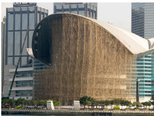
Figura 5. Andamiaje de Bambú en Hong Kong (Lynch, 2016).
