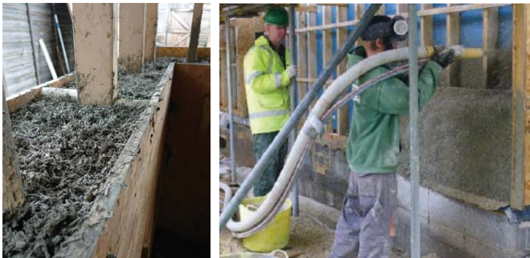
Figura 47. Moldeado In Situ de Muro con Cemento de Cáñamo (Stanwix & Sparrow, 2014).
