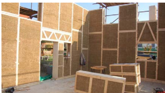
Figura 42. Obra con Paneles Prefabricados (Okambuva.coop, 2021).
