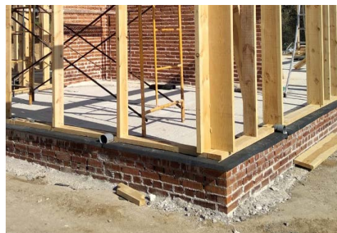
Figura 98. Impermeabilización de la Base del Muro (Minke & Mahlke, 2006, pág. 46).
