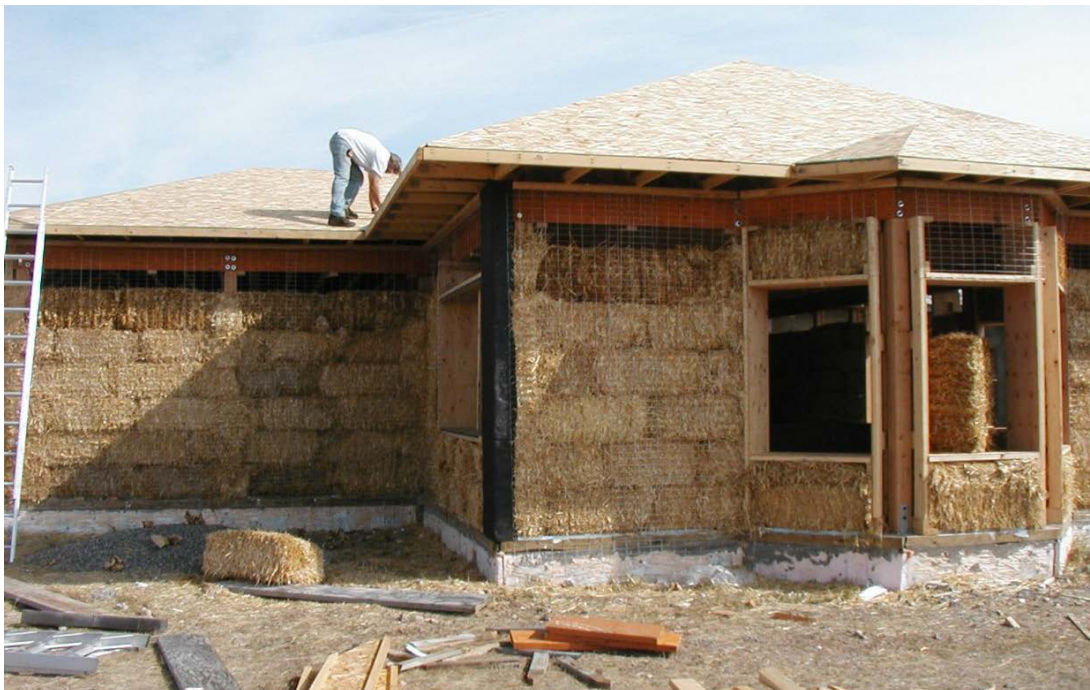
Figura 32. Casa de Postes y Vigas (Simmons, 2018).
