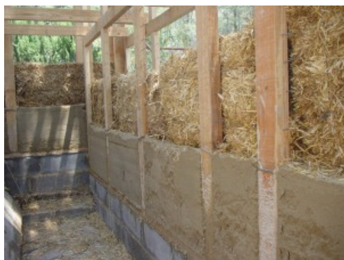
Figura 35. Sistema Greb en Construcción (López, 2021).
