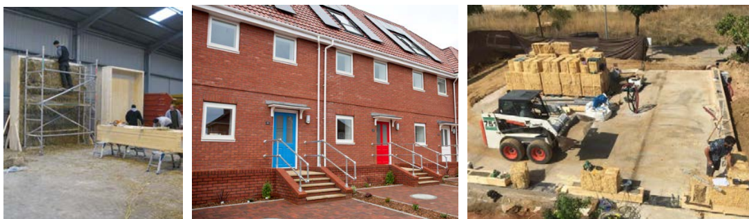
Figura 44. Fabricación Panel ModCell (ModCell, 2021).
