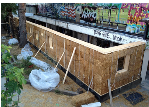
Figura 26. Muro Portante, Acrobax Librería y Sala de Conciertos, Rome, Italy, 2013 (European Strawbale Gathering, 2013).
