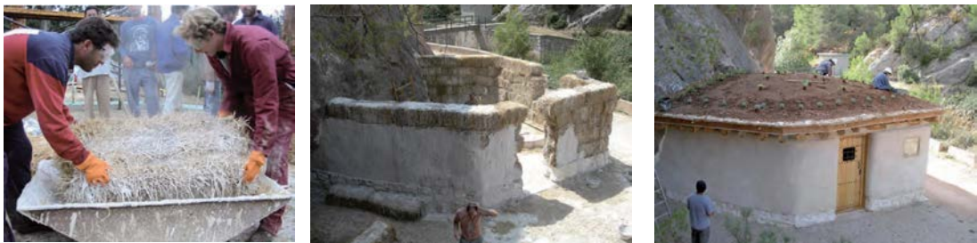
Figura 41. Construcción Paja a la Cal (Nitzkin & Termens, 2010, pág. 95).
